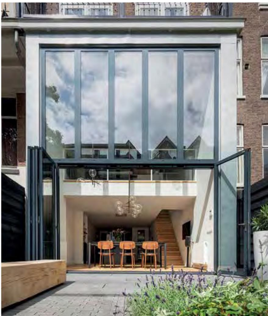
Die Glas-Faltwand öffnet sich im Erdgeschoss über die gesamte Breite von vier Metern.
