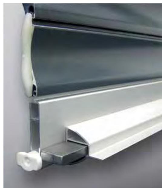
Für die einbruchhemmenden Eigenschaften des nach DIN EN 13659 normgerecht geprüften Rollladens von Alukon sorgen unter anderem vollflächig mit PU-Hartschaum ausgefüllte Aluminium-Rollladenprofile und eine verstärkte, gegen Hochschieben gesicherte Schlussleiste.
