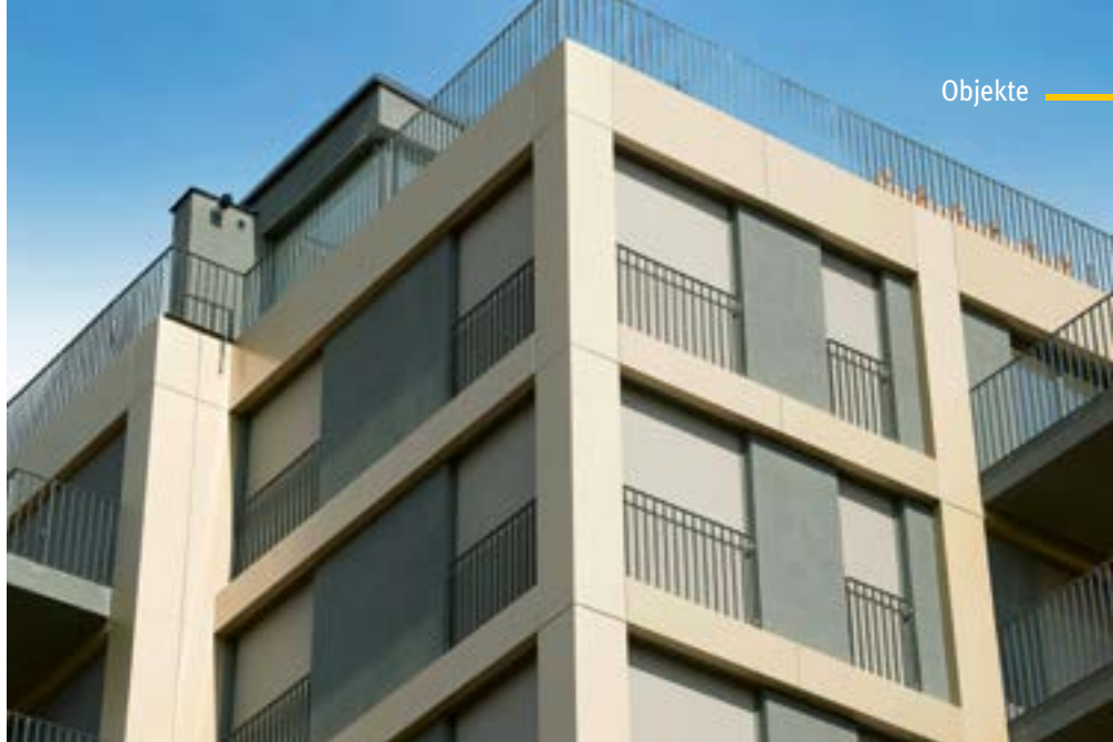
Die Zip-Solidscreens des Sonnenschutzspezialisten fügen sich auch farblich harmonisch in das Gesamtobjekt.
