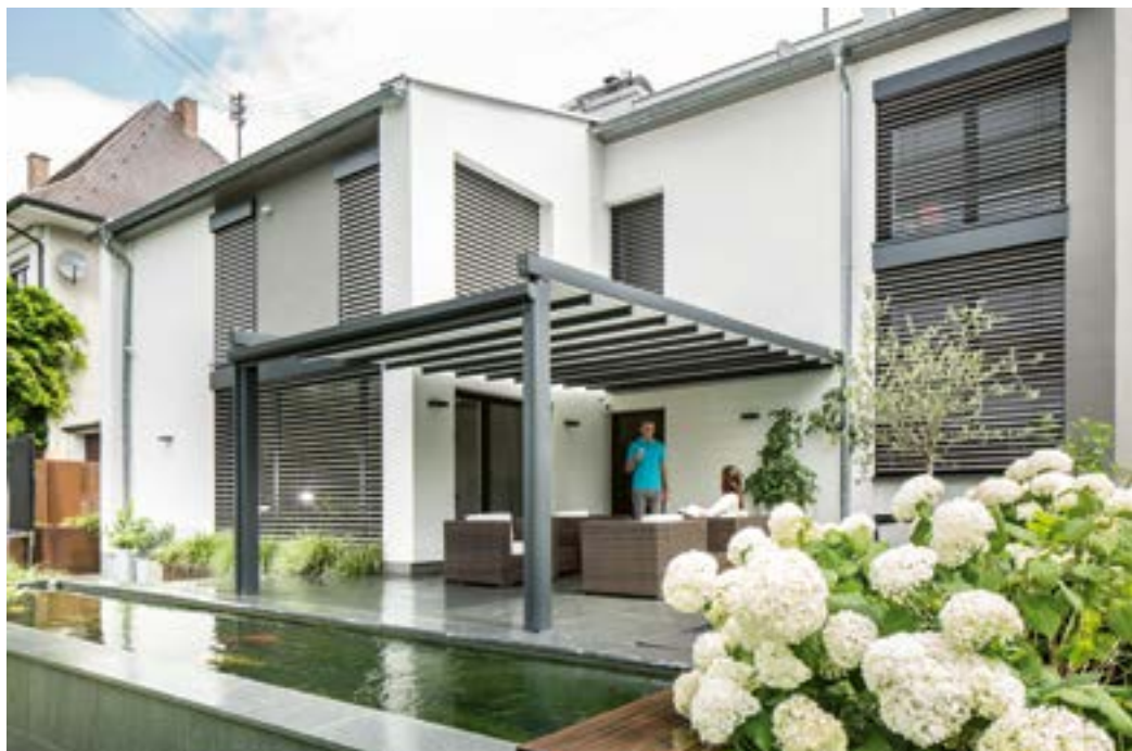
Das neue Markisendach schafft ein zusätzliches Zimmer im Freien.
