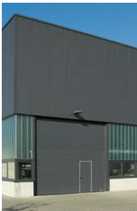
Da die meiste Energie beim Öffnen eines Tores verloren geht, bietet es sich an, das Tor mit einer ebenfalls gedämmten Schlupftür für den Personendurchgang auszustatten.
