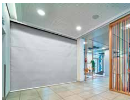
Der textile Feuerschutzvorhang eignet sich vor allem für die Trennung von großen Brandabschnitten in öffentlichen Gebäuden, Hotels oder Kaufhäusern.
