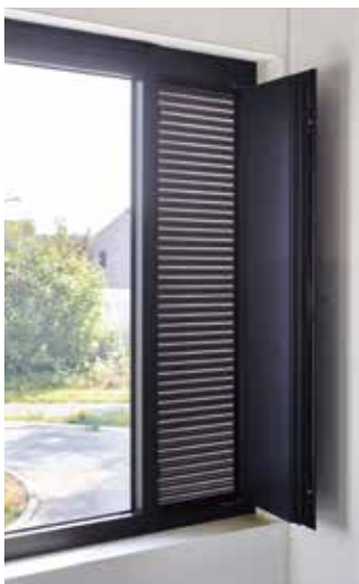
Große Lüftungsklappen sorgen für eine intensive Nachtauskühlung.
