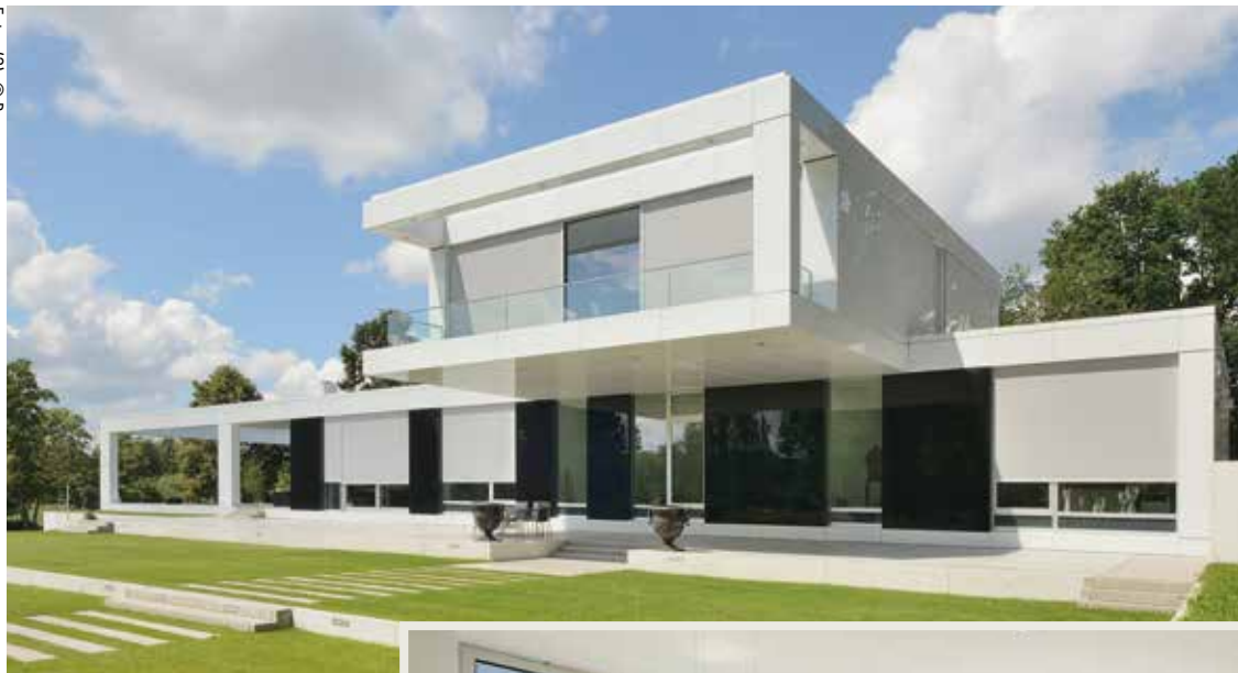
Elegante geradlinige Screens, farbig zum Objekt passend, schützen moderne Architektur vor Überhitzung im Sommer.
