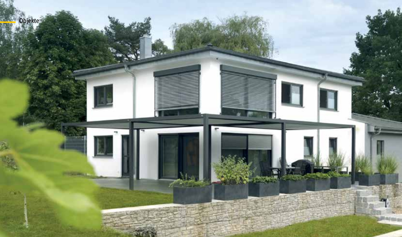
Außenjalousien, Pergolen und Rollläden werden in diesem Einfamilienhaus über die Smart Home-Lösung gesteuert.
