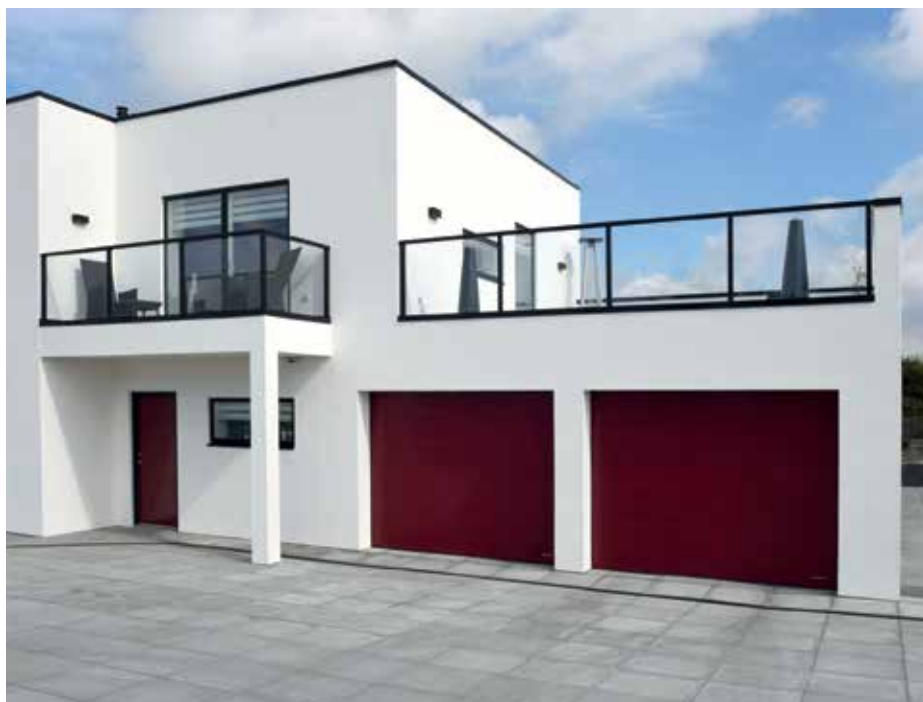
Tore tragen zur Energiebilanz eines Gebäudes bei.
