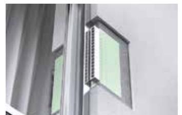
Ob in Aufsatz- oder Einbaukästen, Komplettsystemen oder wie hier als systemunabhängiges Laibungsmodul – AIRFOX<sup>®</sup> erfüllt die DIN 1946-6.
