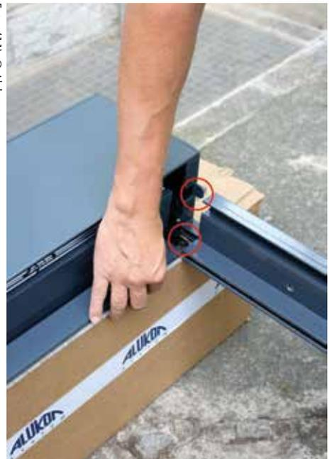
2. Bei Auslieferung des Raff-E sind das Lamellenpaket und in dieser Ausführung ein optional erhältliches Insektenschutzrollo bereits werkseitig im Kasten integriert sowie die Grund- und Führungsschienen so vorbereitet, dass direkt mit der Montage begonnen werden kann. Diese werden wie beim Vorbaukasten einfach aufgesteckt. Blendkappenzapfen und eine Zunge an der Blendkappe, die in die Grundschiene greift, verhindern ein Verdrehen und sorgen für eine sichere Positionierung.
