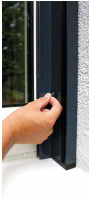
10. Im letzten Schritt werden die mitgelieferten und im passenden RAL-Ton lackierten Abdeckkappen zum Verschließen der Schraubbohrungen in den Führungsschiene eingeklipst. Nach einer fachmännischen Funktionsprüfung ist die Montage des Raff-E abgeschlossen.
