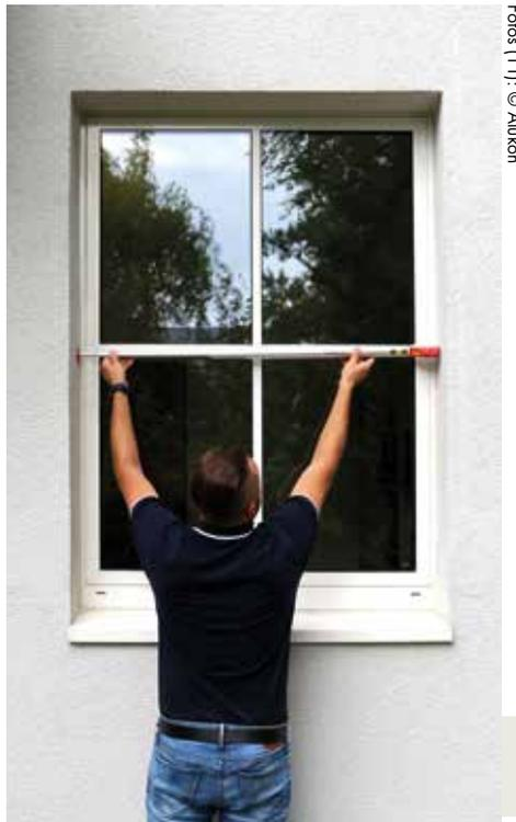
1. Beim Raff-E wird die Elementgröße einfach durch das lichte Öffnungsmaß (Breite x Höhe) ohne komplizierte Berechnungen bestimmt und ist somit auch ohne tiefergehende technische Produktkenntnisse möglich. So können Alukon Partner bereits vor der Montage Zeit sparen und Fehler beim Aufmaß vermeiden.
