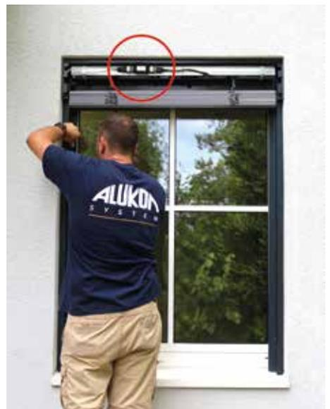
8. Der Raff-E von Alukon verfügt serienmäßig über einen Antrieb, der durch die werkseitige Vormontage bereits bei Auslieferung im Kasten integriert ist. Alternativ zur kabelgebundenen Bedienung kann dieser auch via Funk per Hand- oder Wandsender bedient werden. Hierzu wird ein Funkempfänger zwischen zwei Hirschmann Steckern montiert.
