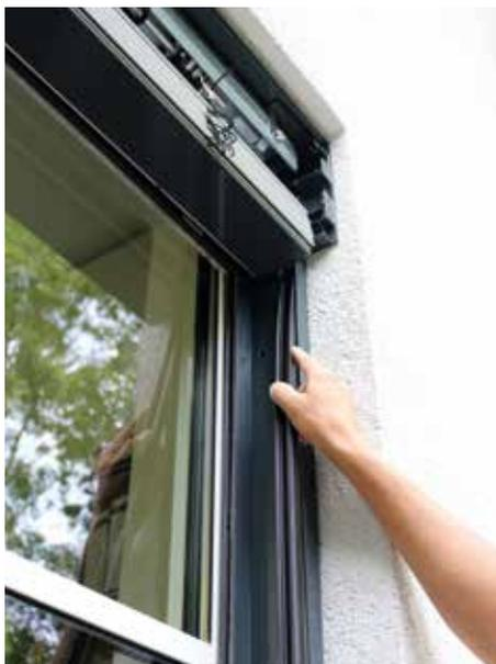
6. Anschließend werden die Führungsschienen für die Raffstorelamellen in die Grundschiene eingeklipst. Die Führung des optional erhältlichen Insektenschutzrollos ist durch die werkseitige Vormontage des Raff-E bereits nach der Montage der Grundschiene gegeben und bedarf keiner weiteren Arbeitsschritte.
