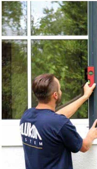
4. Durch das Nachjustieren der Grundschiene wird überprüft, ob diese waagrecht eingebaut sind. Dies stellt sicher, dass der Behang nach Abschluss der Montagearbeiten reibungslos geöffnet und geschlossen werden kann.
