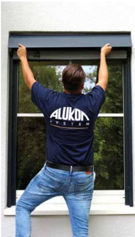
9. Im Anschluss wird die Blende des Raff-E durch zwei verdeckt liegende Schrauben befestigt. Durch die verdeckte Blendenbefestigung sind an der Vorderseite des Kastens keine Schrauben oder Nieten sichtbar. Trotz dessen ist der Kasten für Montage- und Wartungsarbeiten gut zugänglich, indem die Blende durch die zwei Schrauben schnell und einfach geöffnet werden kann.
