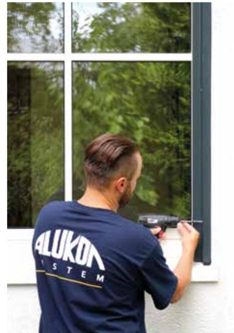
5. Wenn sichergestellt ist, dass das Element waagrecht eingebaut ist, werden die Grundschiene festgeschraubt und so mit der Fensterlaibung verbunden. Die schlagregendicht konstruierten Aluminium-Grundschiene des Raff-E können nach der Montage auch überputzt werden.
