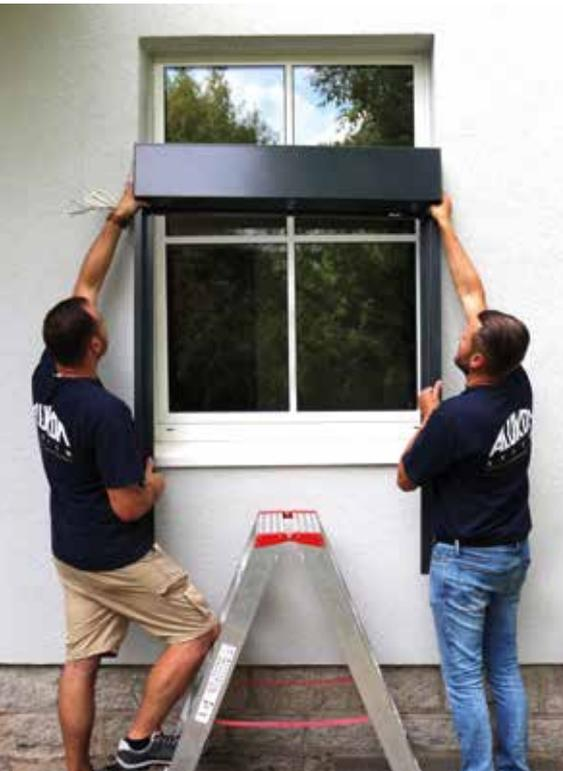
3. Bei der Variante als sichtbarer Kasten in der Laibung wird der Raff-E für die weitere Montage als komplettes Element in die Fensterlaibung gestellt.
