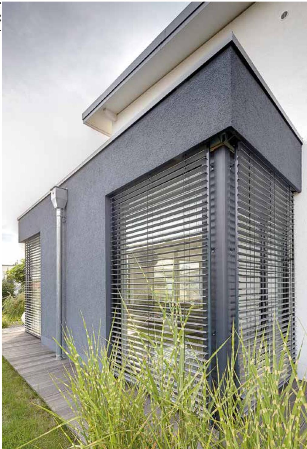
**Autarke Sonnenschutzsysteme reagieren durch die Vernetzung mit verschiedenen Sensoren automatisch auf äußere Bedingungen.**
