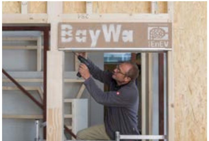
Als einbaufertiges Element ist der Holzfaser-Rolladenkasten leicht und zeitsparend montiert.
