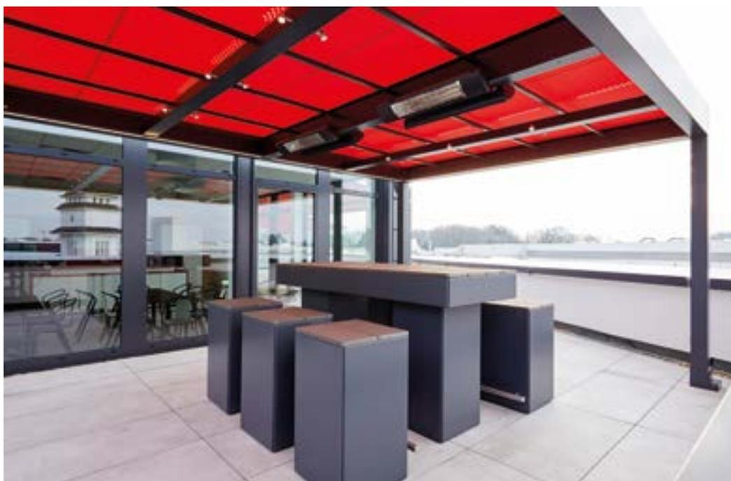
Per Knopfdruck heizt der Infrarotstrahler energieeffizient und mit smarter Technik auch größere Flächen unter einer Markise auf.
