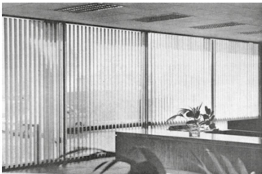
geschieht bei manueller Bedienung durch eine bzw. zwei Perlketten oder Schnurzug. Der Lichtdurchlaß läßt sich stufenlos bis zur fast völligen Ausschaltung regeln; soll das Fenster frei bleiben, so lassen sich die Lamellen zu schmalen Paketen zur Seite ziehen.
