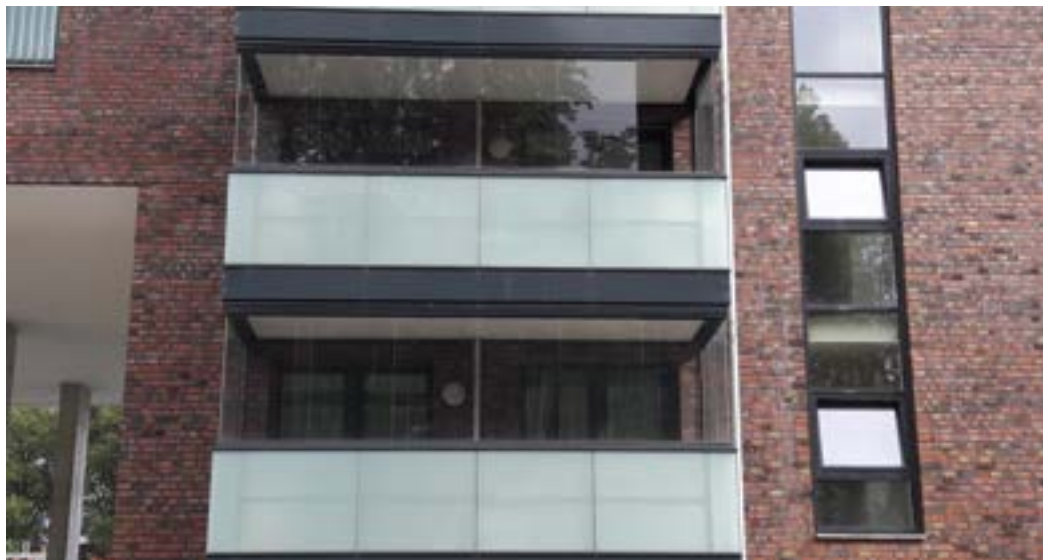
Eine Vergasungslösung, die in Hamburg umgesetzt wurde.
