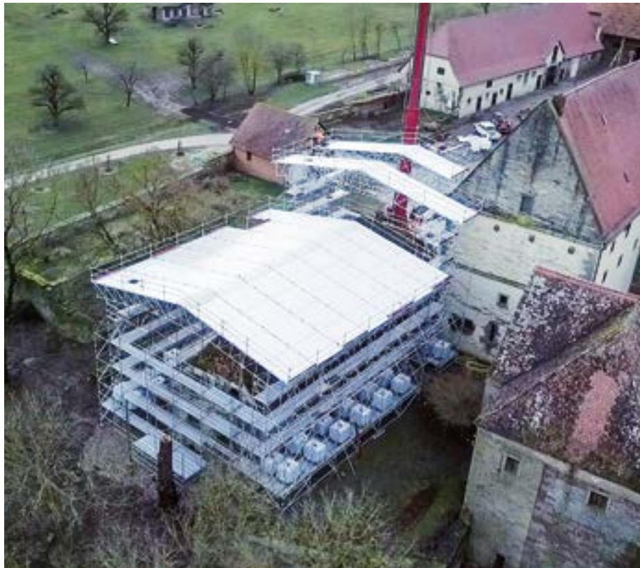
Durch die verschiedenen Standardlängen ließ sich die Unterkonstruktion für das Wetterschutzdach bei der Sanierung des Zisterzienserklosters Rechentshofen einfach und schnell an den leicht abschüssigen Geländeverlauf anpassen.
