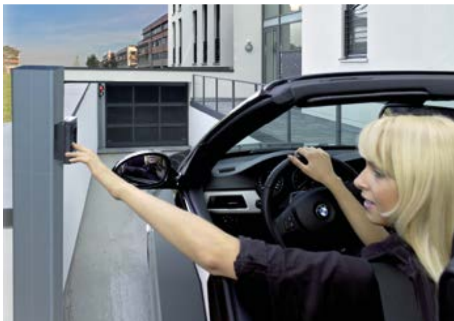
Im Standardbetrieb öffnen die Torantriebe den Eingang zur Tiefgarage mit 13 cm/s.
