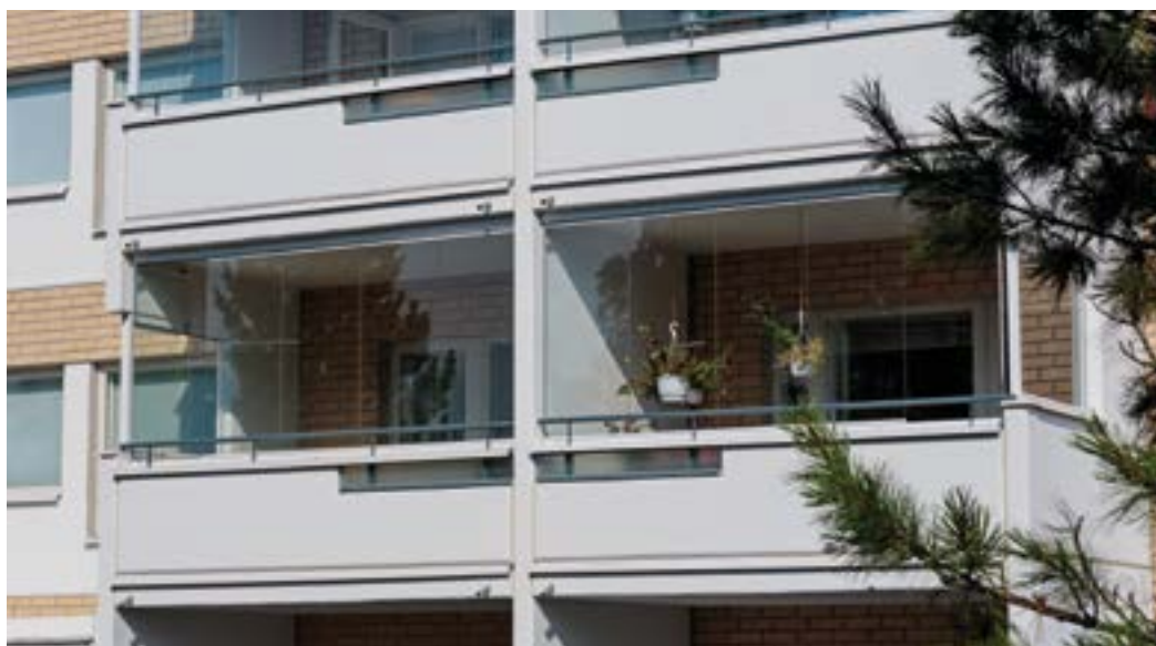
Hier wurde eine „normale“ Balkonfassade verglast.
