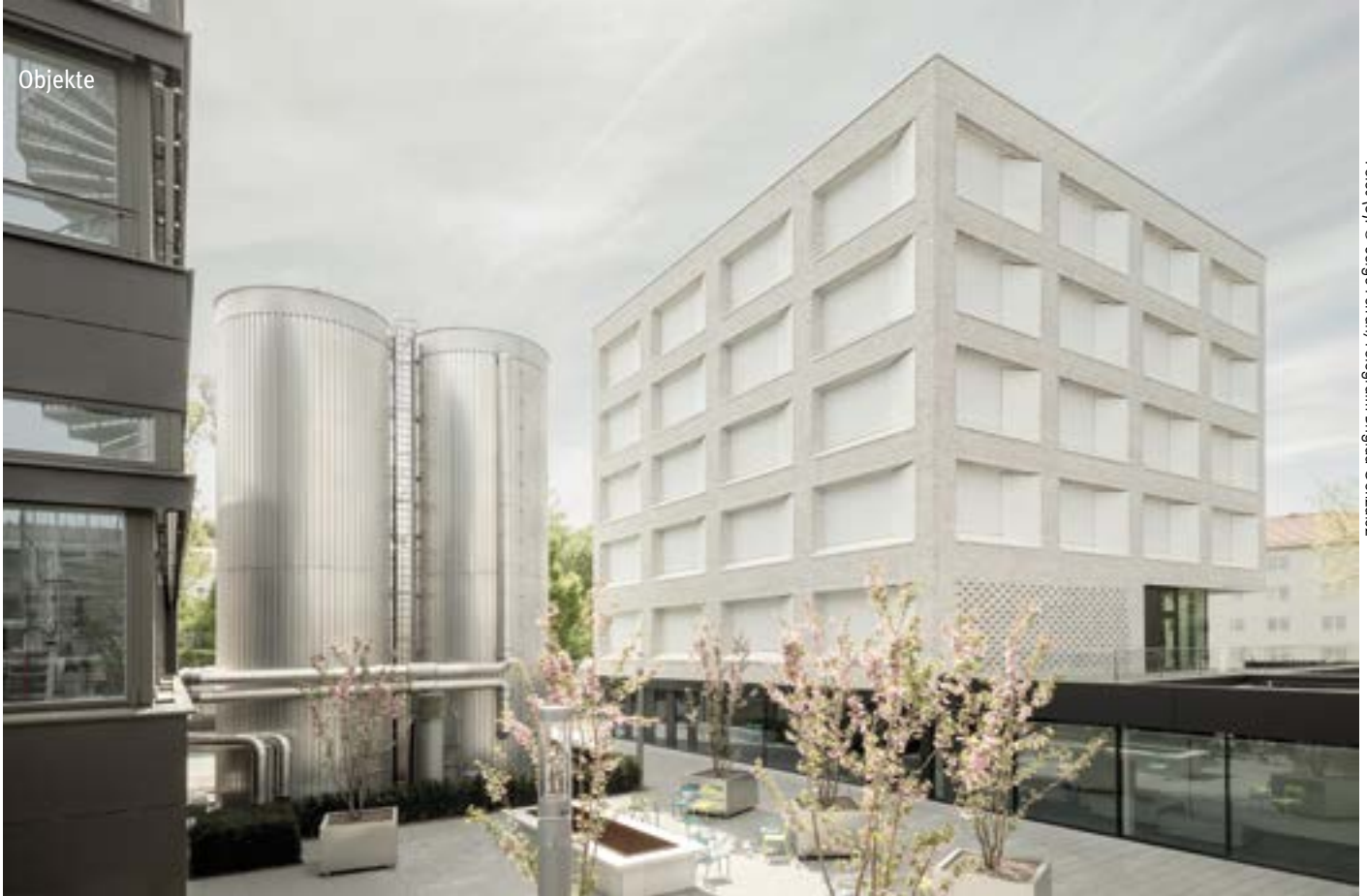
Die Fassadenmarkisen in Weiß unterstützen die monochrome, kontrastierende Fassadengestaltung.
