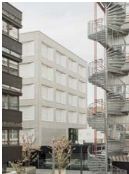
Die Fassadengestaltung verbindet, wirkt aber auch selbstbewusst.
