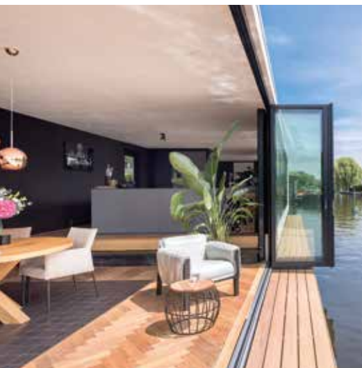
Die Glas-Faltwand realisiert weite Fassadenöffnungen.
