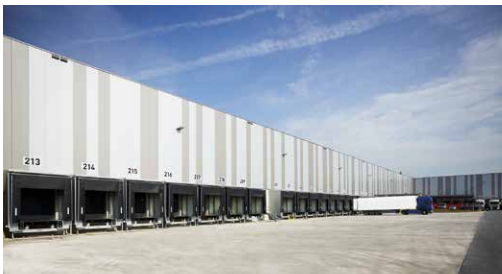
Unter anderem 407 Industrie-Sectionaltore, Ladebrücken und Vorsatzschleusen sowie Schnelllaufstore, Feuerschutz-Schiebetore und Türen wurden in Marl installiert.
