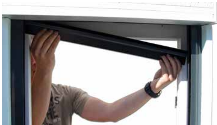
Das Abrollprofil ist am Blendrahmen verschraubt und kann jederzeit abgenommen werden.
