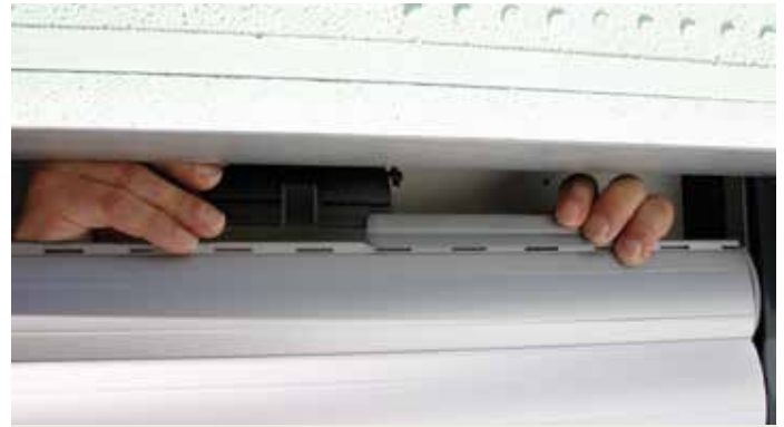
Feste Wellenverbinder sind insbesondere für Motoren mit automatischer Endlagenabschaltung geeignet.
