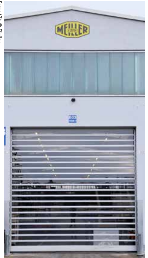
32 dieser Schnelllauf-Turbotore wurden bei laufendem Betrieb eingebaut.
