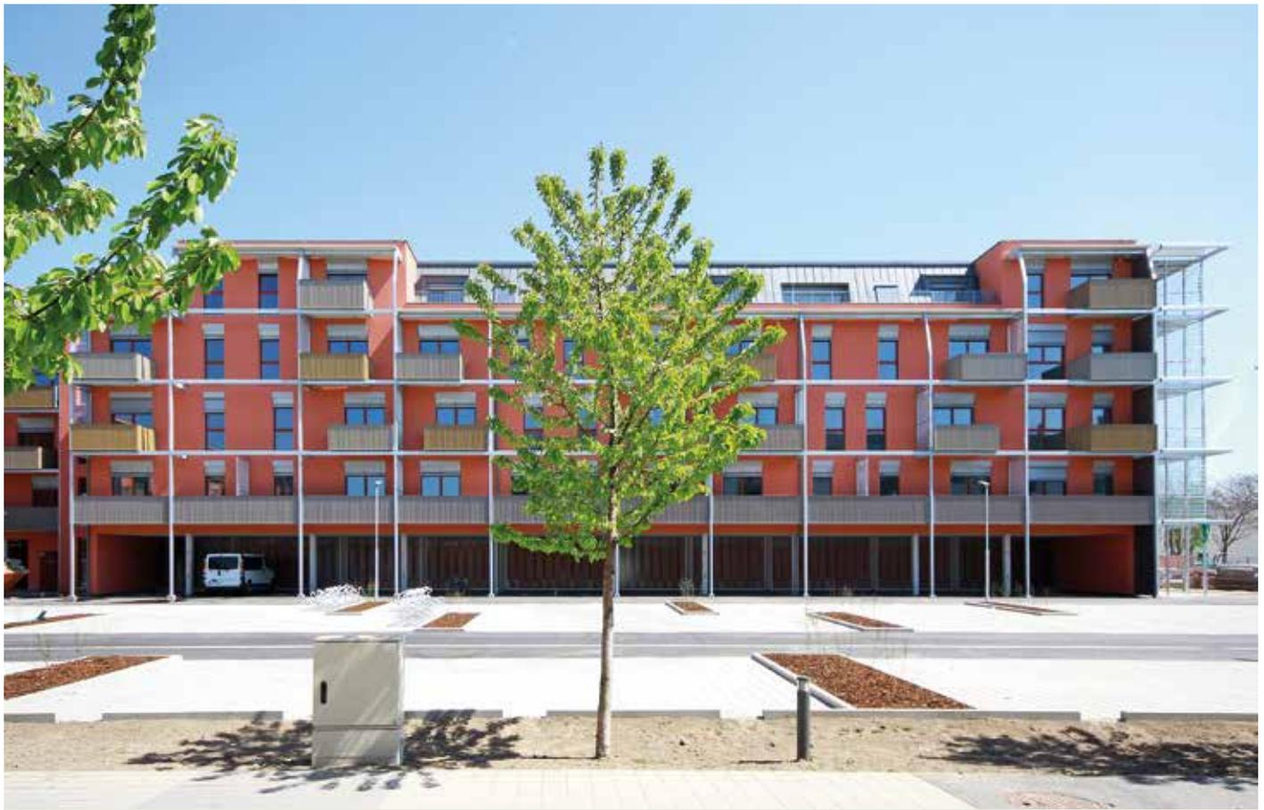
Die Sonnenschutzkästen sind sichtbar ausgeführt, sitzen in der Fensterlaibung und bündig mit der Putzfassade.
