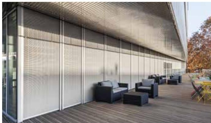
Die einfallende Lichtmenge kann durch Öffnen und Schließen des Behangs bis hin zu kompletter Verdunkelung bestimmt werden.
