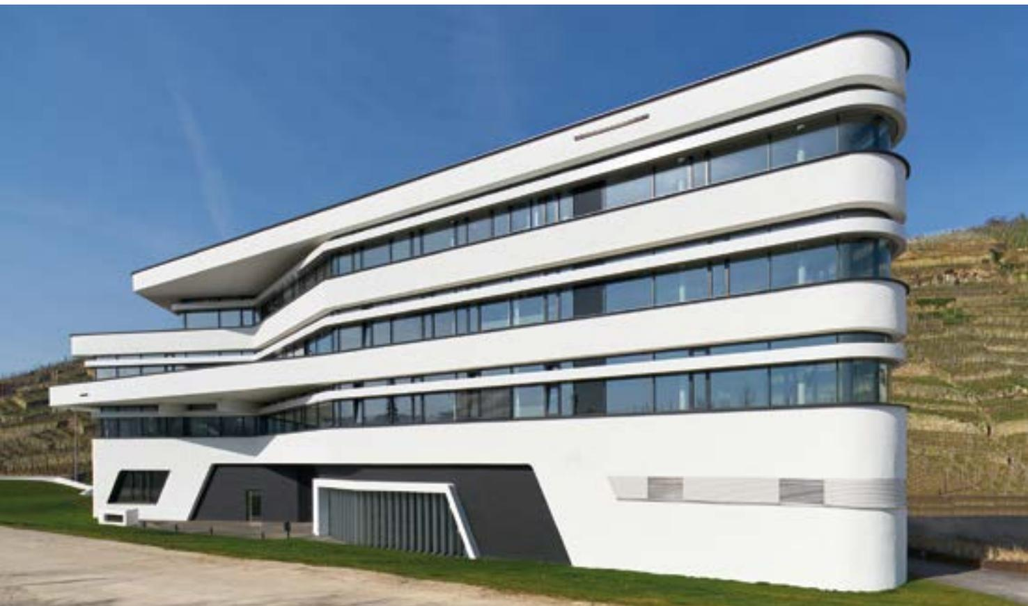
Von außen lassen die schmalen Profile die Fassade wie durchgehende Fensterbänder wirken.
