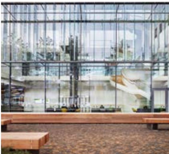
Für die gläserne, rund 23,5 mal 18 Meter große Atriumfassade, wurde ein spezielles Statik- und Montagekonzept entwickelt.
