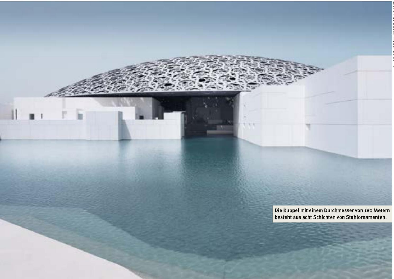
Die Kuppel mit einem Durchmesser von 180 Metern besteht aus acht Schichten von Stahlornamenten.
