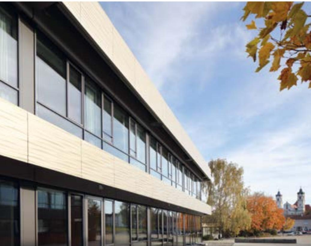
Die Beschichtung der Fassadenbänder kann auch funktional punkten: Die Einbrennlackierung ist UV-stabil, chemisch beständig und kradet nicht aus. So wird das Gebäude auch noch in ferner Zukunft gepflegt wirken.
