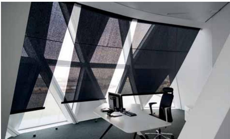
Die Tuchwellen wurden verdeckt zwischen Glasfassade und Decke installiert, was zu einer besonders dezenten Integration des Sonnenschutzes führte.
