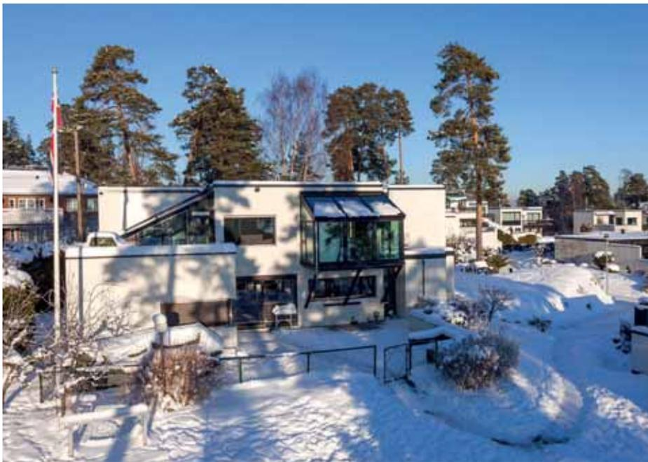
Der Wintergarten ist vor das 1. OG des Haupthauses gesetzt. Die Lasten werden über schräge Stützen auf die Grundmauer abgetragen.
