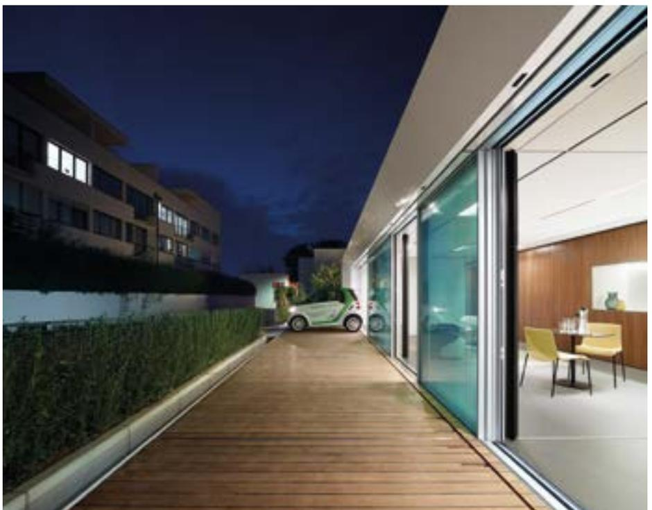
Die Terrasse lässt sich in Teilen hydraulisch nach oben klappen und ermöglicht ein vollständiges Schließen der verglasten Gebäudeseite.
