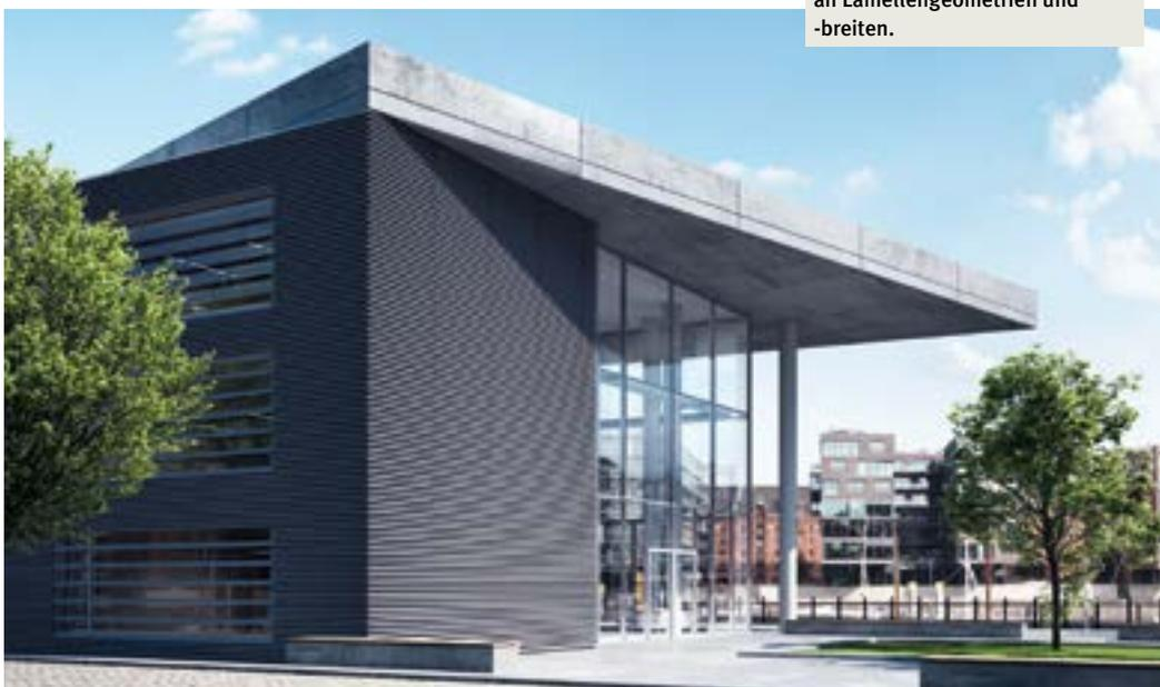
Hier wird das Lamellensystem als Witterungsschutz für die großflächige Wandgestaltung eingesetzt.
