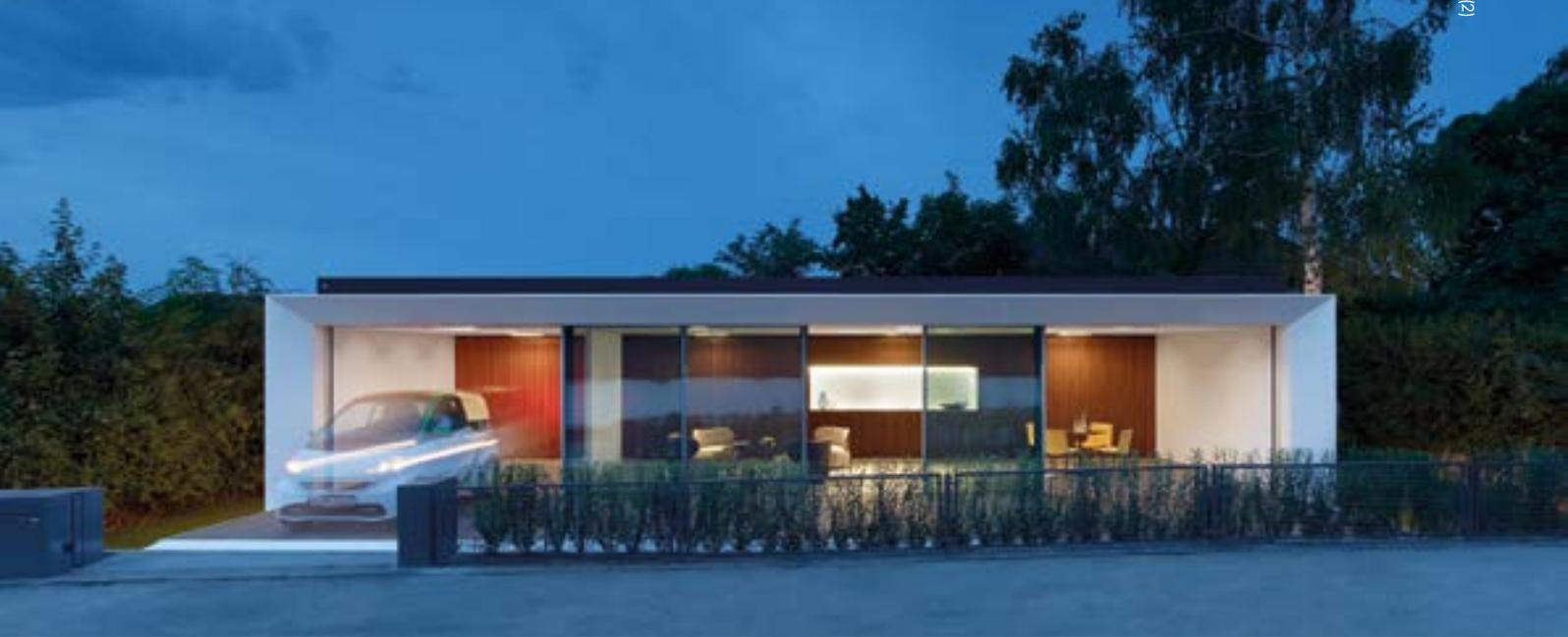
Das Aktivhaus ist als modulares Gebäude konzipiert und setzt sich aus im Werk vorgefertigten Bauteilen zusammen.
