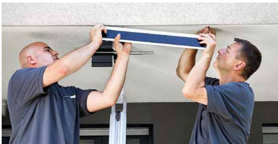
Das elero-Solarpanel versorgt die DC-Antriebe des Herstellers mit Sonnenenergie.
