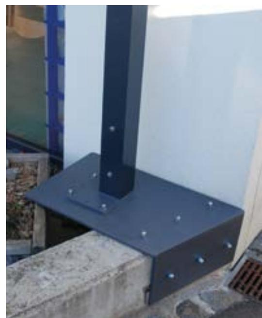
Bei der freitragenden Konstruktion musste einer der Stützpfeiler auf einer Mauer befestigt werden.
