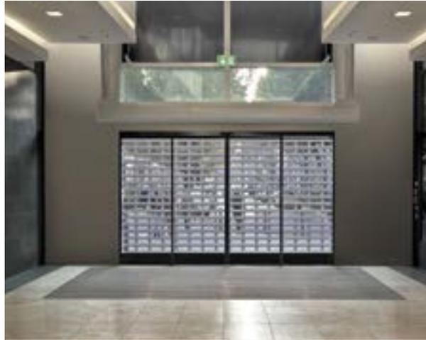
Für sichere Ladenabschlüsse stellt die Kombination aus Automatik-Schiebetür und Rollgitter eine barrierefreie und einbruchhemmende Lösung dar.
