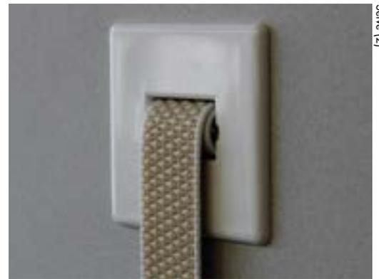
So sieht die neue Gurtführung nach der kompletten Montage aus: Das Raststück mit Rolle wurde auf den eingeputzten Grundkörper geschoben.
