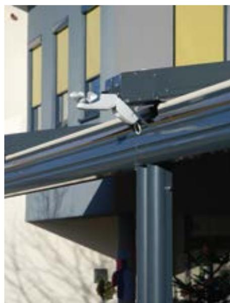
Die Pergola-Markise kann bis Windstärke 6 ausgefahren bleiben. Bei stärkeren Winden wird über einen Windsensor das Signal zum Einfahren gegeben.
