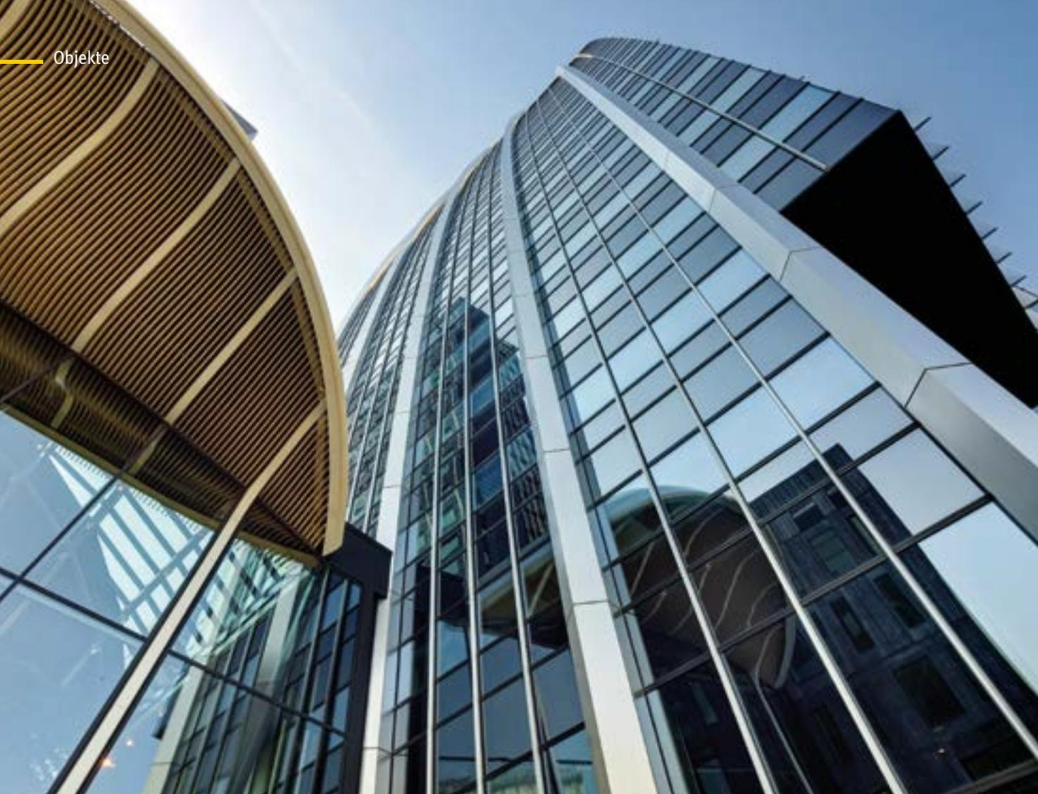
Die charakteristische Krümmung des Neubaus entsteht durch die Neigung der einzelnen, in sich selbst nicht gebogenen Fassadenelemente.
