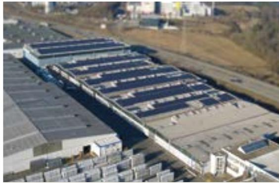
Für die EEG-konforme Photovoltaikanlage wurden auf insgesamt fünf Dächern der Werkshallen insgesamt 4583 Module verbaut.
