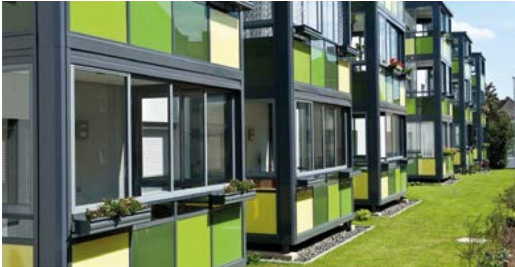
Das Verglasungssystem aus pulverbeschichtetem Aluminium und Glas zeichnet sich durch hohe Flexibilität, einfache Handhabung und elegantes Design aus.
