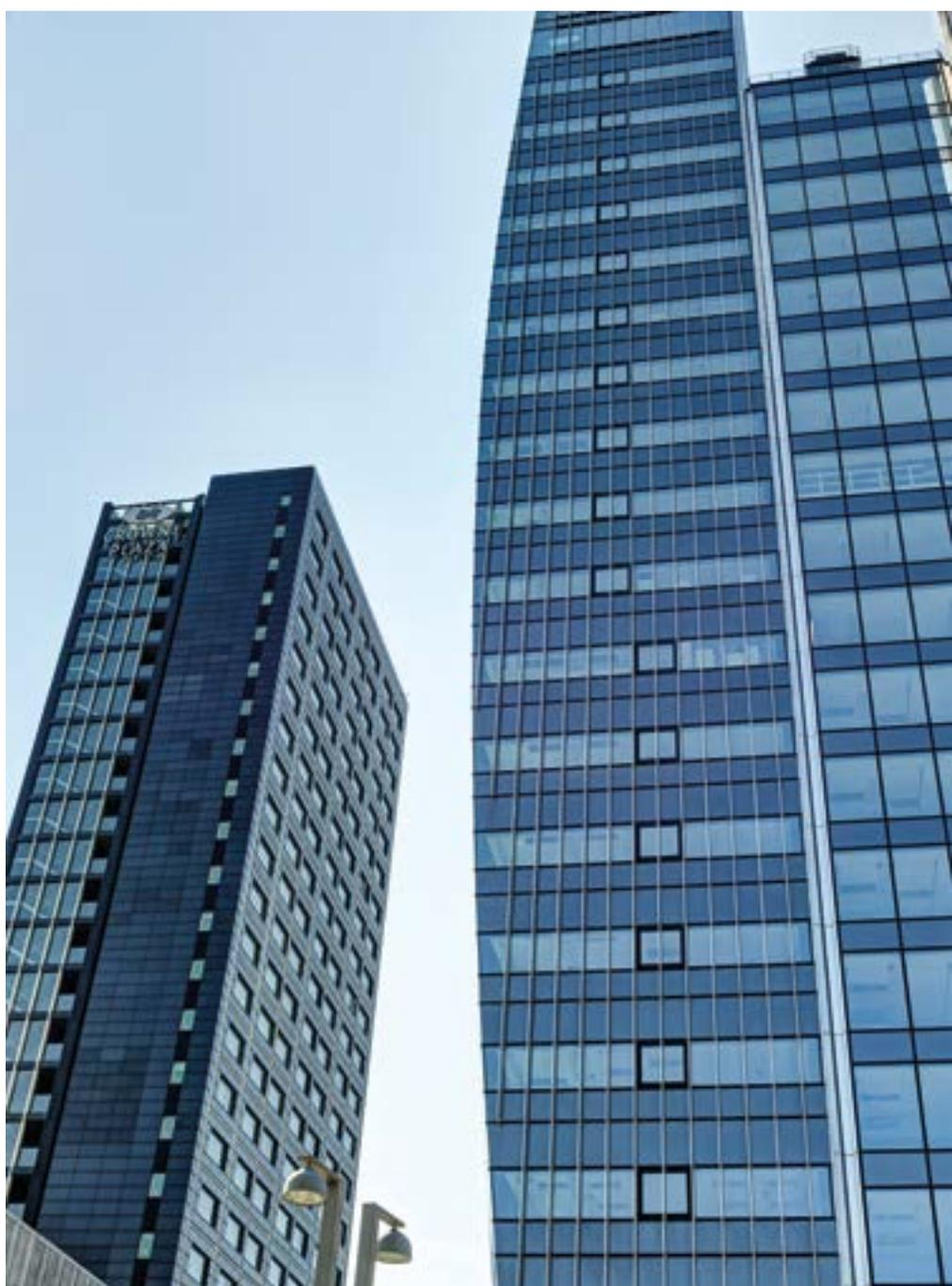
Um den Eindruck einer Ganzglasfassade zu erzielen, wurden in die nichttransparenten Paneele Sicherheitsgläser mit keramischer Bedruckung eingebaut.
