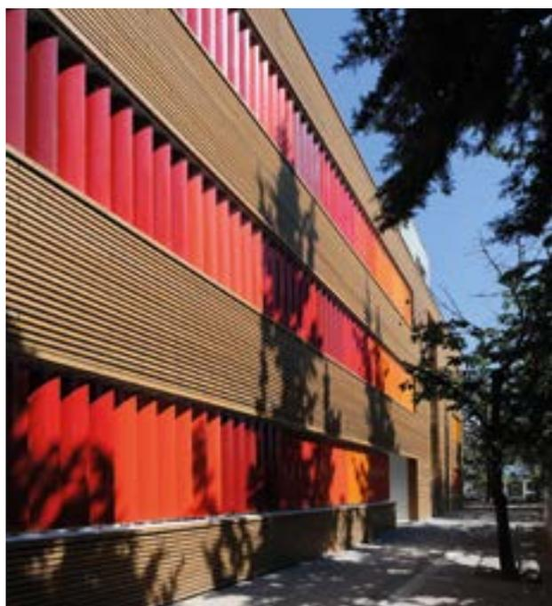
Die 255 Millimeter breiten Hohllamellen in Ellipsen-Optik sind über das Sonnenschutz-Steuerungssystem automatisiert.
