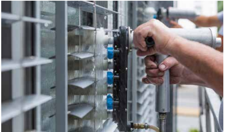
Es wurde parallel in zwei Gondeln gearbeitet, was zu Optimierung der zeitlichen Abläufe beitrug.
