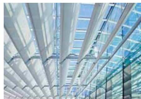
Präzise und sicher bewegen die Lösungen Lamellen und sorgen so für Sichtschutz sowie optimale Nutzung von Tageslicht und Sonnenwärme.
