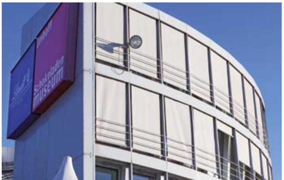
141 Fassadenmarkisen inklusive Motoren und Steuerungen wurden geplant und erneuert.
