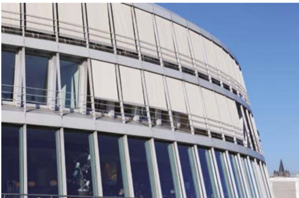
Die robusten und langlebigen Motoren laufen äußerst ruhig sowie leise und schonen die Markisentücher durch einen automatischen Behanglängenausgleich und einen Sanftanschlag in der oberen Endlage.
