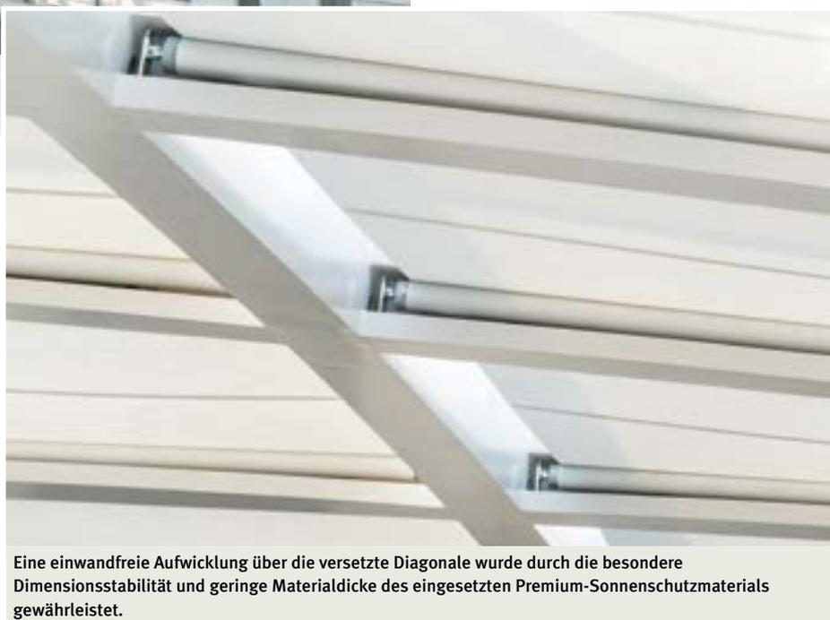
**Eine einwandfreie Aufwicklung über die versetzte Diagonale wurde durch die besondere Dimensionsstabilität und geringe Materialdicke des eingesetzten Premium-Sonnenschutzmaterials gewährleistet.**
