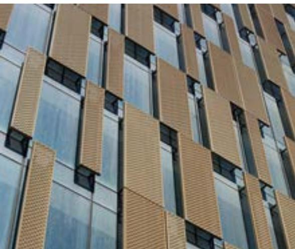
**Den Kontrast zu den reflektierenden Sonnenschutzverglasungen bilden feststehende Sonnenschutz-Paneele mit brillantgoldenen, transluzenten Flächen.**
