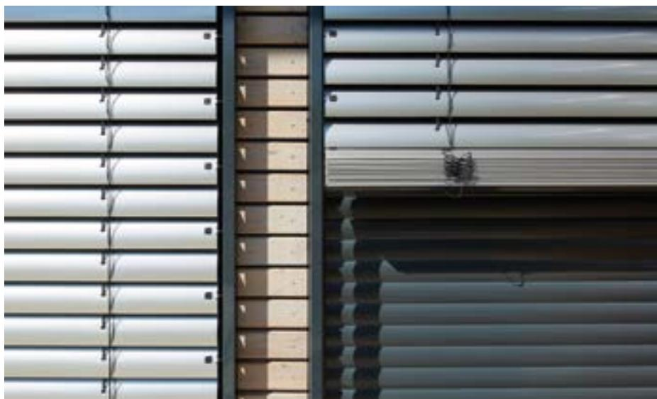
Die gewählten einbruchhemmenden Rollläden liegen direkt am Fenster, außen davor sind die Raffstoren gesetzt. Sie werden durch seitliche Schienen sicher geführt.
