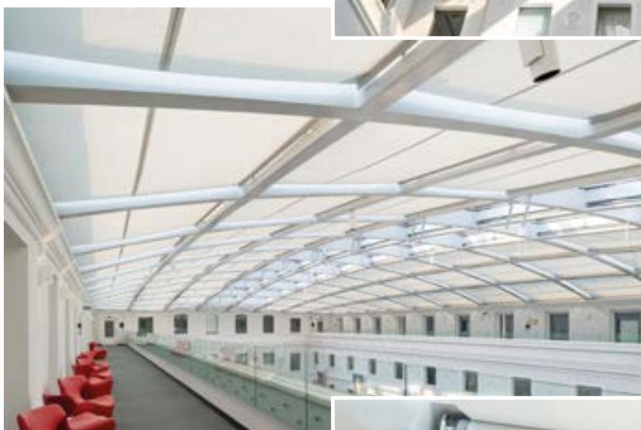
**Das Glasdach wurde in Form eines Ellipsoids konstruiert, mit einem Tragwerk, in dem 104 Felder entstanden.**
