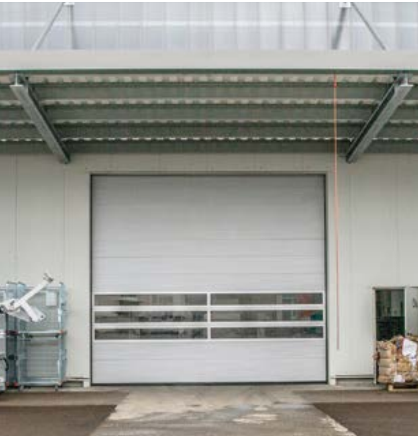
In dem neuen Produktionsgebäude in Salem bietet das Tor für Logistiker beste Voraussetzungen.
