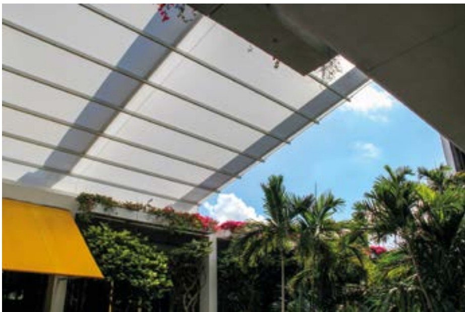
Ausgefahren und straff gespannt bildet das Gewebe ein flaches, transparentes Dach.
