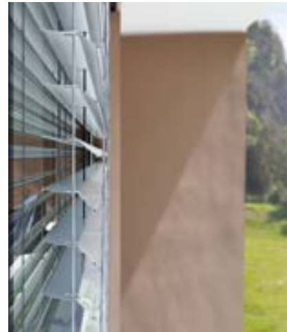
Das Geheimnis des Tageslichttraffstores liegt in den beiden Teilstücken der Lamelle.
