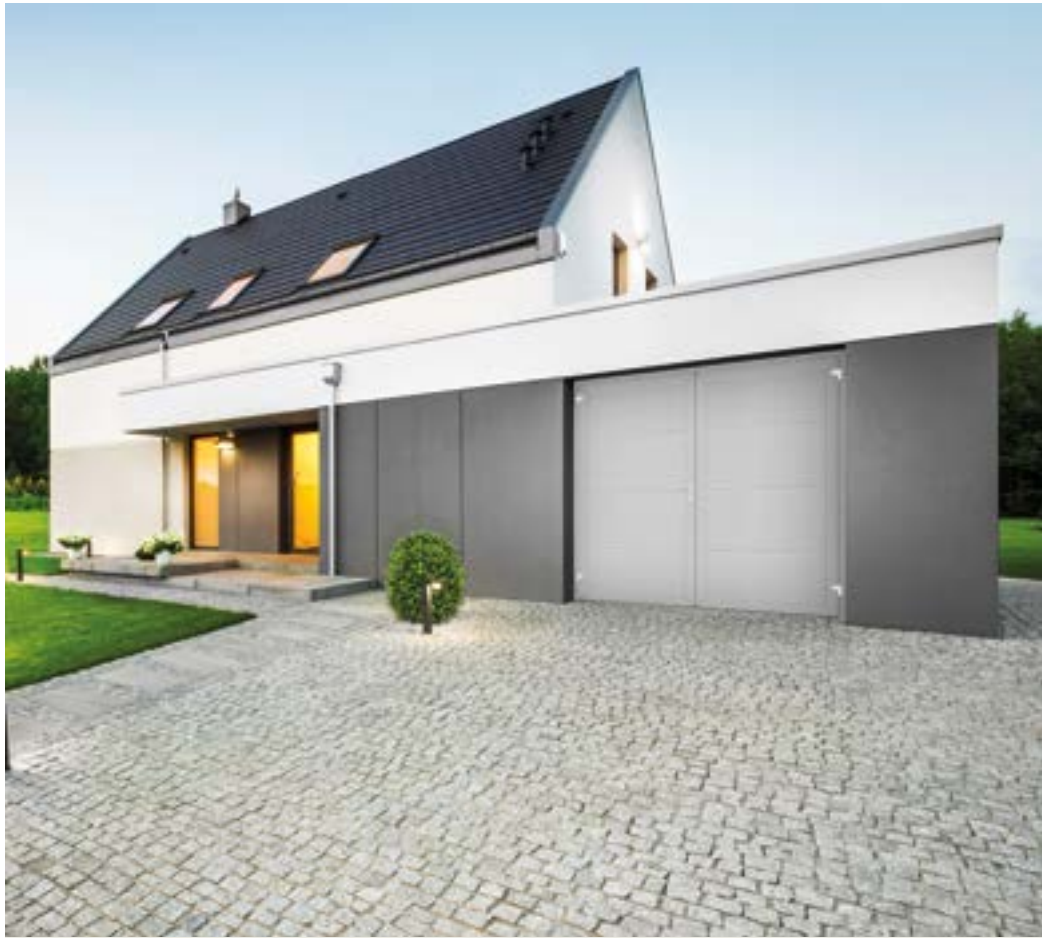
Das wärmegeämmte Drehflügelator ist zudem ein repräsentativer Nebeneingang.
