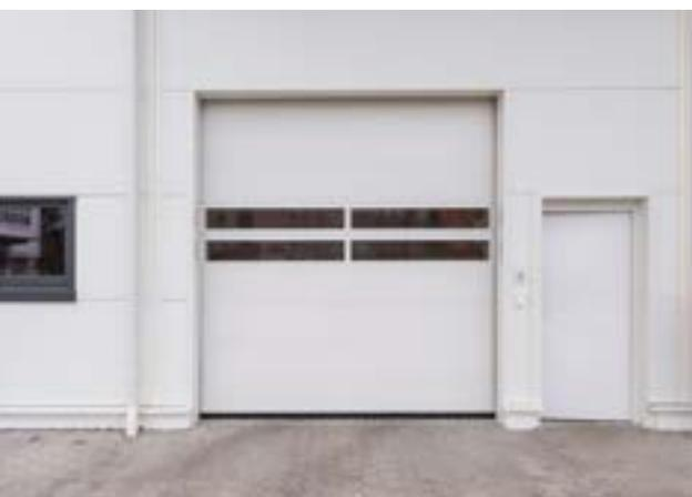
Mit seinen Maßen von 3 Metern Breite und 3,18 Metern Höhe überzeugt das eingebaute Helix-Tor auch durch seine Kompaktheit.
