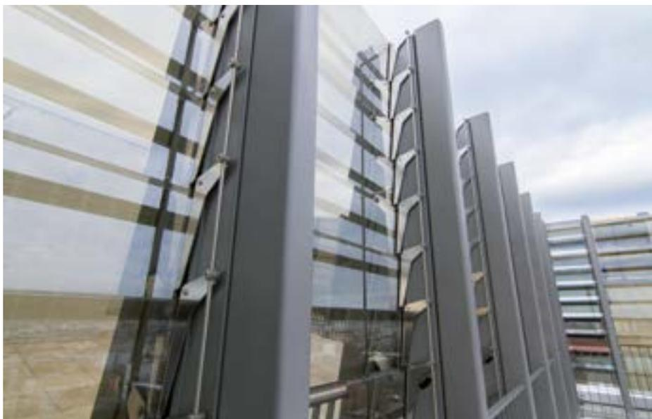
Effizienter Schutz vor Wind und zu grellem Sonnenlicht bei gleichzeitig optimalen Belüftungsverhältnissen.
