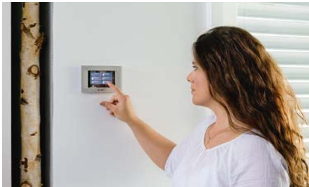
**Per MultiTec Touch-868 können Marion Haubner und Familie die Haustechnik zentral vom Wohnzimmer aus steuern – ein Berühren des modernen Displays mit übersichtlicher Oberfläche genügt. Jalousien, Screens, Rollläden und Beleuchtung können in 20 Kanäle eingelernt und einzeln, in individuell eingeteilten Gruppen oder alle zugleich angesprochen werden. Auch eine Zeitschaltuhr für automatische Abläufe ist integriert.**
