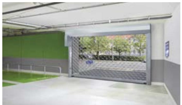
Platzsparend wird das Tiefgaragentor hinter dem Sturz montiert.
