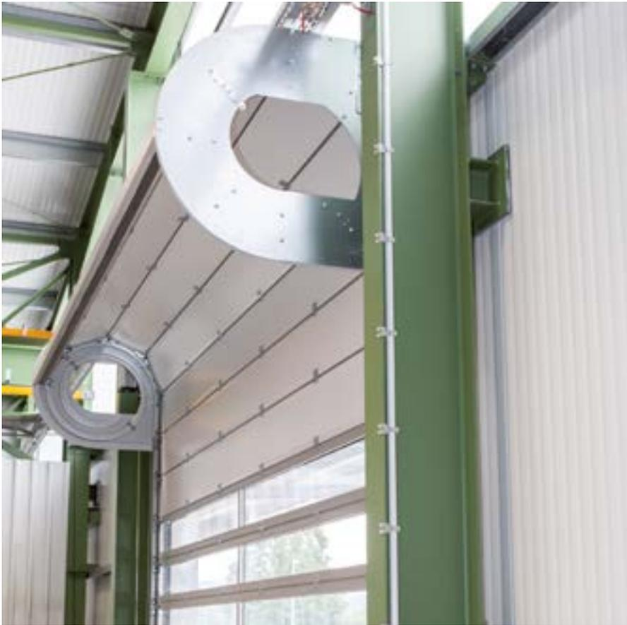
Die innovative Spiraltechnologie ermöglicht ein extrem schnelles, leises und platzsparendes Aufrollen.
