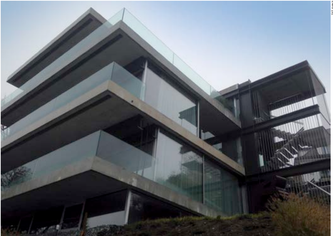
In dem Mehrfamilienhaus werden die Beschattungen komfortabel gesteuert.
