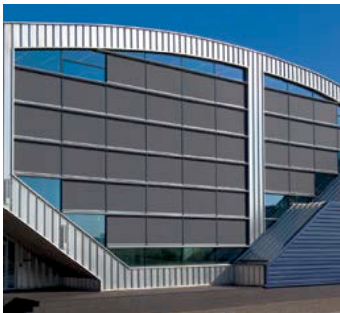
Die Sonnenschutzgewebe bieten optimalen Blend- und Wärmeschutz.
