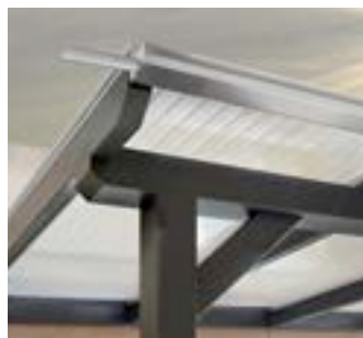
Kunststoffplatten überzeugen als Terrassenüberdachung mit hoher Robustheit und Durchsichtigkeit.
