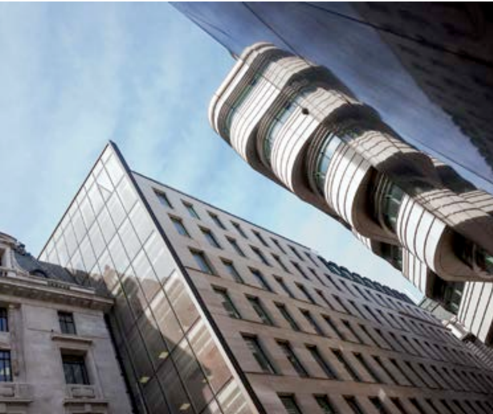
In London wurde das Projekt „St. James’s Market“ mit einem Auftragsvolumen von rund 8,5 Millionen Euro realisiert.
