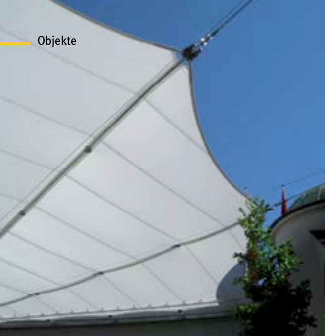
Die schützende Membran überdacht in ausgespanntem Zustand innerhalb kürzester Zeit eine Grundfläche von 210 Quadratmetern.
