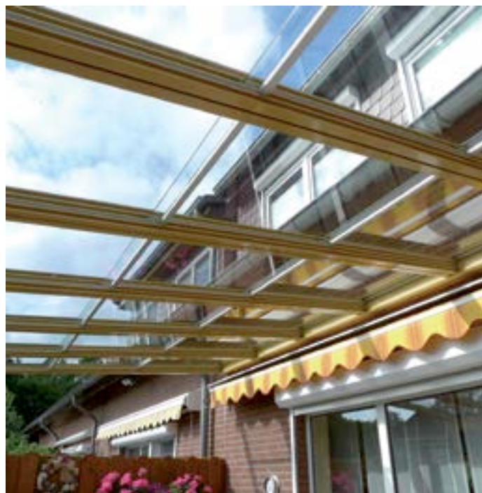
Durch die Aluminium-Konstruktion der Hohlkammerprofile entstehen eine besonders hohe Statik und dauerhafte Belastbarkeit der Rahmenprofile.
