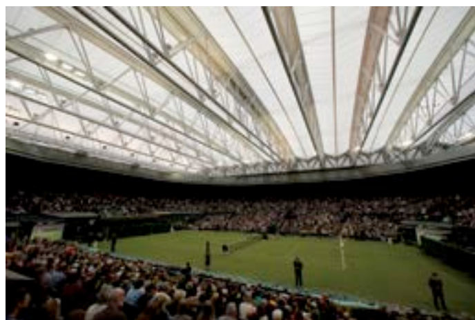
Mit einem Lichttransmissionsgrad von 38 Prozent herrscht selbst bei geschlossenem Dach für Spieler und Besucher „Open-Air-Atmosphäre.“
