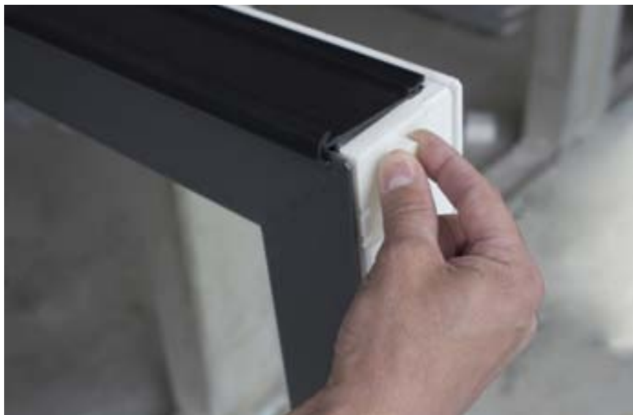
Im ersten Montageschritt wird das Adapterprofil auf dem Fensterprofil eingerastet.
