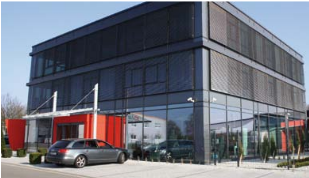
Durch die geringe Pakethöhe wird weniger Platz für den Blendkasten des Raffstores benötigt, was den Energieverlust verringert.
