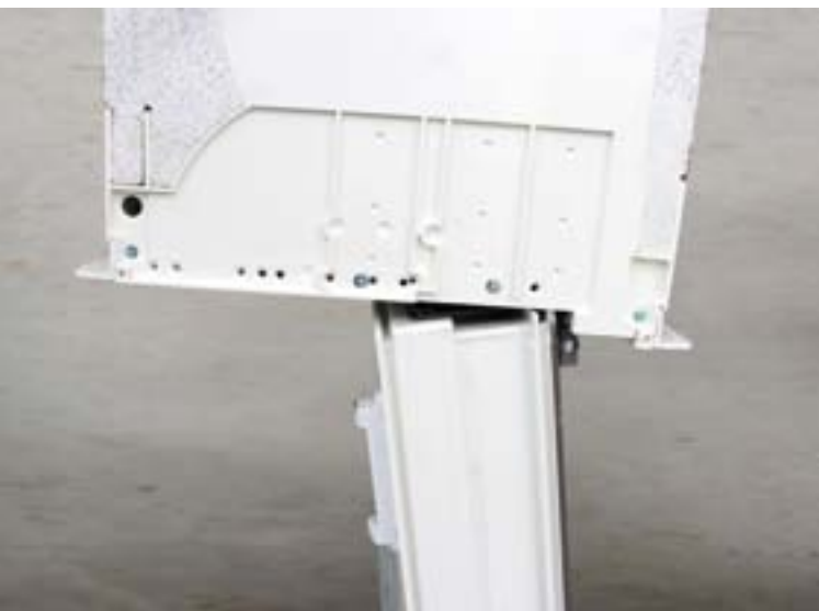
Der Kasten des Systems wird auf dem Blendrahmen des Fensters positioniert.
