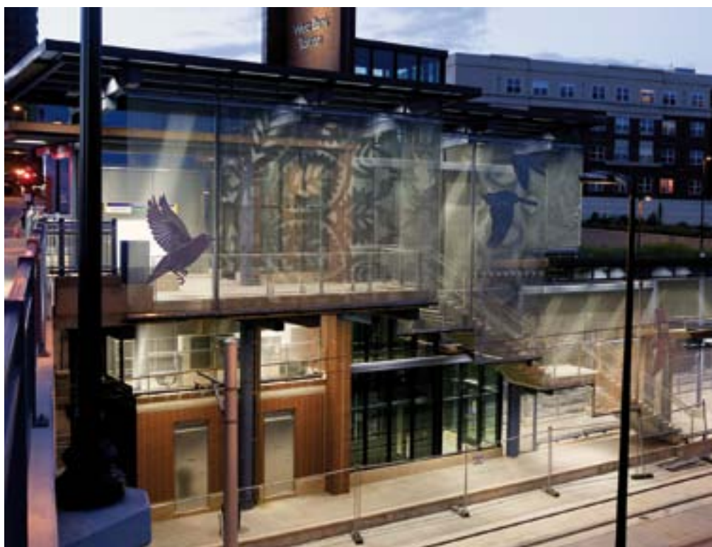
Außen angebrachte Strahler setzen gezielte Lichteffekte, die sich je nach Position des Betrachters verändern und so das transparente Gewebe unvermutet opak wirken lassen.
