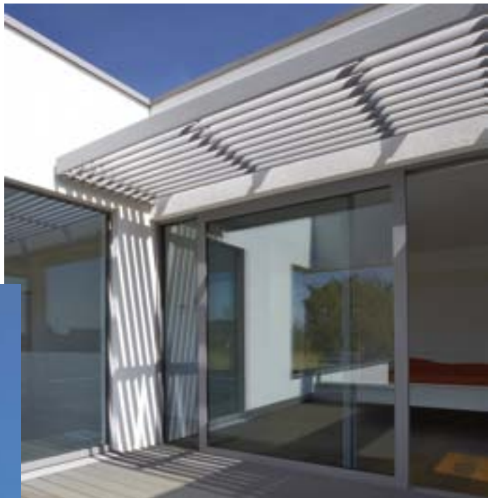
Je höher die Sonne im Sommer steht, umso weniger erreicht sie den Raum hinter dem Fenster.
