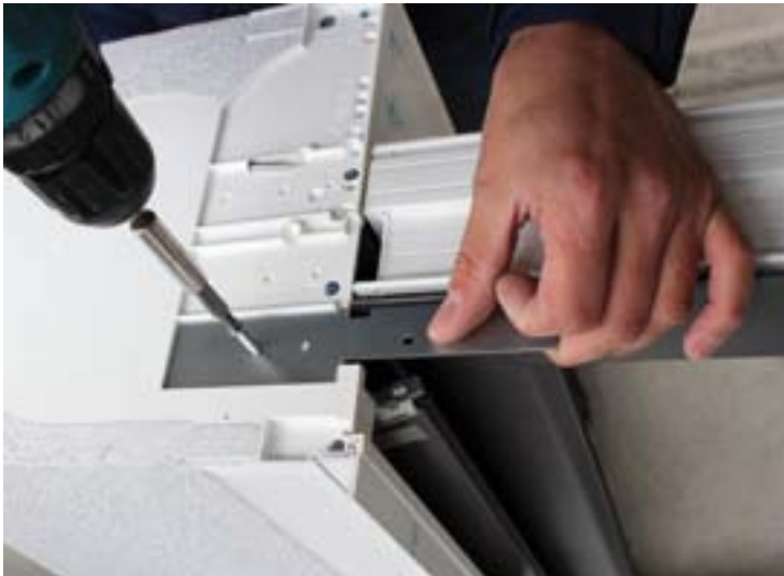
Passt die Positionierung, werden Befestigungslaschen rechts und links an die Kopfstücke des Kastens und an den Blendrahmen des Fensters geschraubt.
