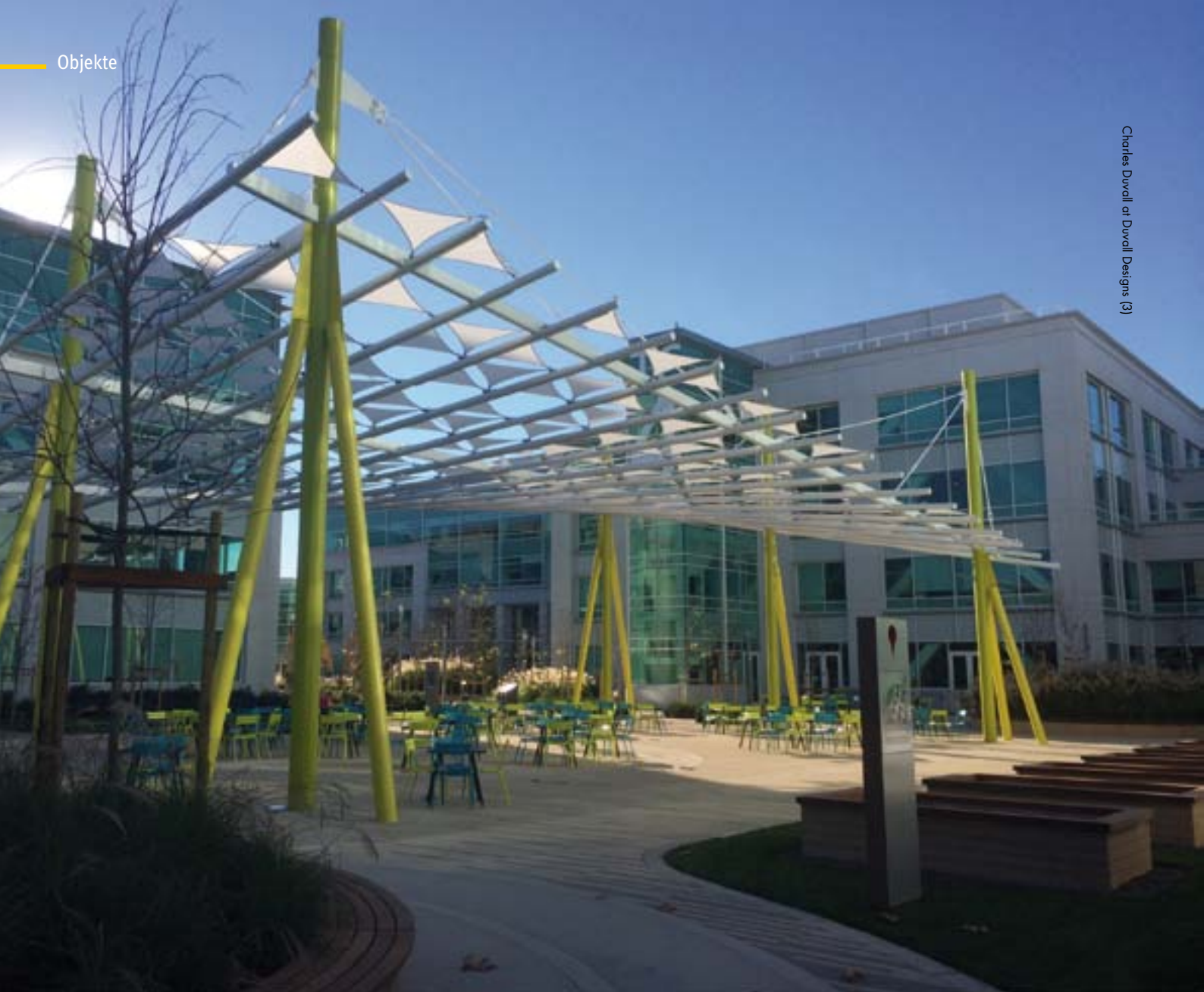
Wie ein Blätterdach überspannt eine aufwendige Konstruktion den Platz zwischen vier Gebäuden.
