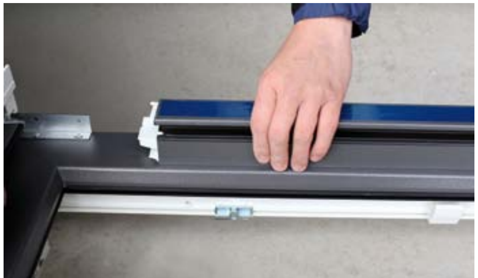
Anschließend werden die Führungsschienen mit dem werkseitig vormontierten Einlaufrichterunterteil nah am Kasten aufgesetzt.
