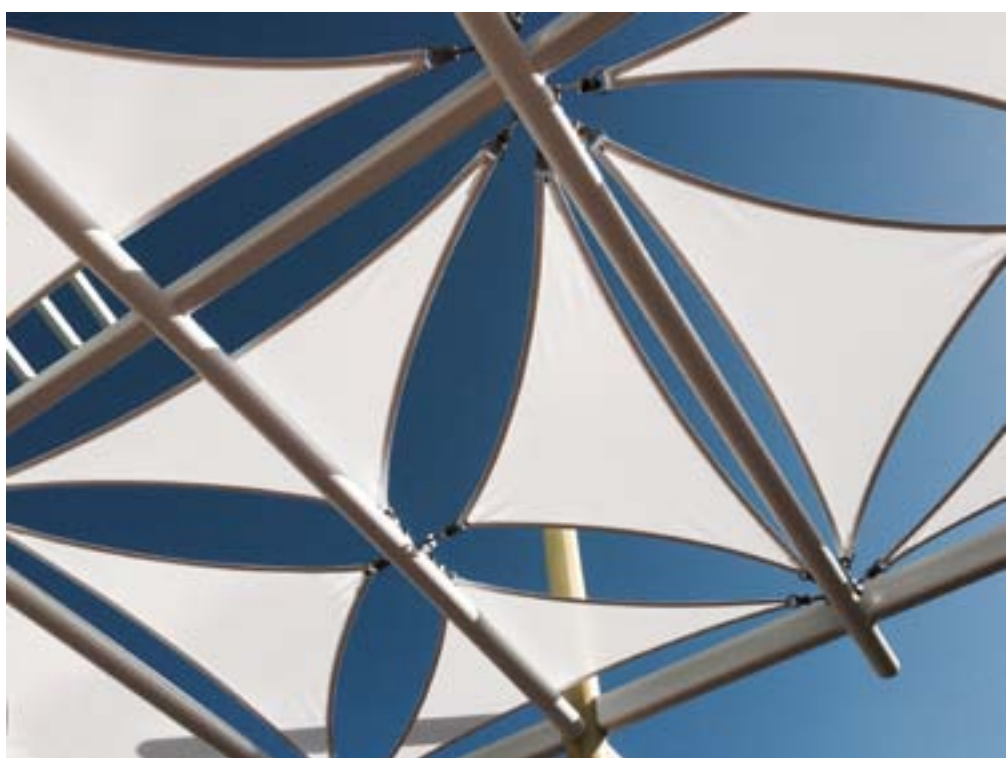
Luftig durchscheinend fügen sich die triangelförmig beschnittenen Segel in neun unterschiedlichen Größen innerhalb eines vorgegebenen Stahlgitter-Rasters zueinander.
