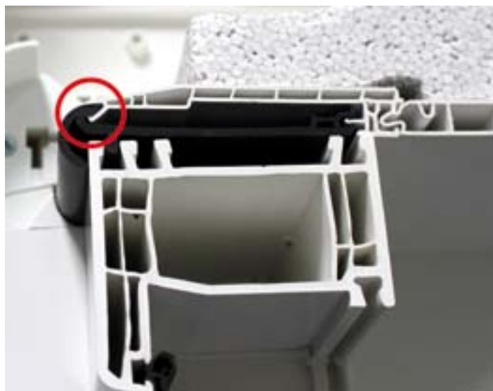
Anschließend wird der Kasten auf die richtige Positionierung überprüft.
