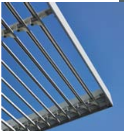
Der strukturelle Sonnenschutz schützt vor hochstehender Sonne.
