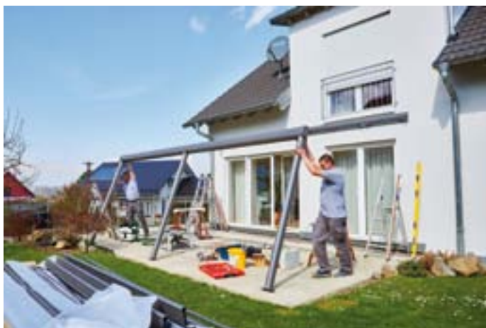
Das Terrassendach und die Wintergarten-Markise waren schnell montiert.
