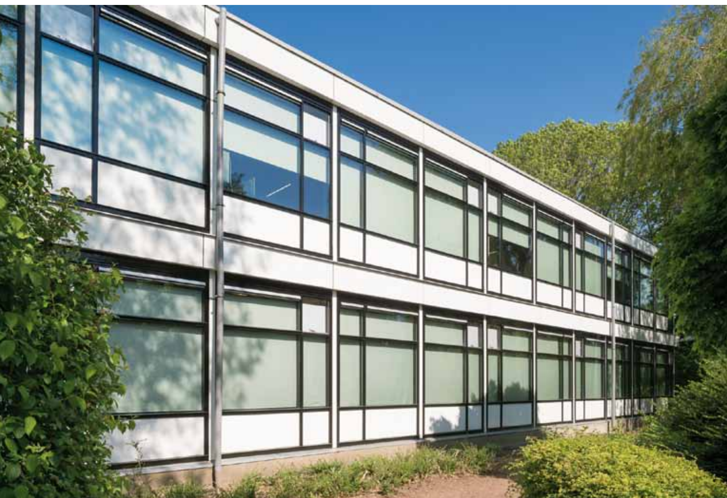
Insgesamt werden 265 Rollos in den Klassenräumen montiert.
