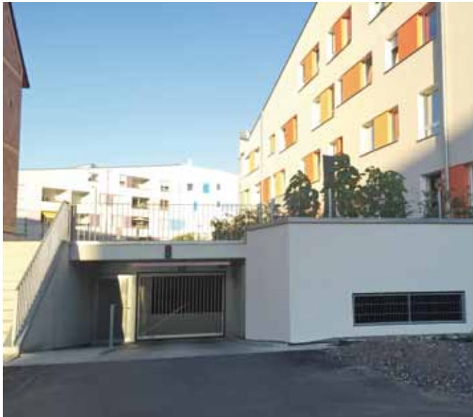
Um der maximalen Belastung einer Tiefgarage Stand zu halten, werden die Torflügel grundsätzlich aus Aluminium gefertigt.
