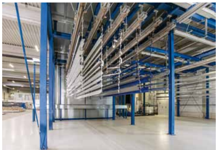
Die Shuttles mit den fertig beschichteten Markisenteilen: Eine neu entwickelte Software sorgt für eine optimale Bestückung.
