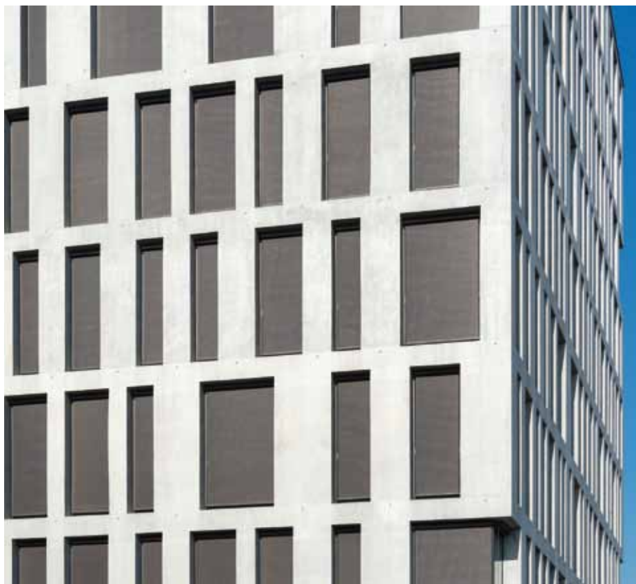
Das Material verfügt über eine hohe mechanische Beständigkeit und Reißfestigkeit, um starken Wind- und Sogkräften widerstehen zu können.
