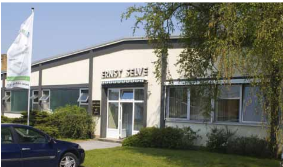
In dem Zweigwerk in Bad Arolsen dreht sich alles um Gurtwickler – nun nach den Vorgaben von „Lean Production“.
