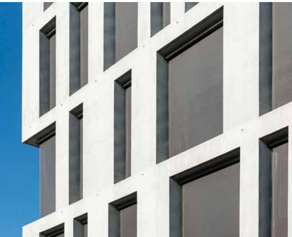
Damit sich das Sonnenschutzmaterial beim Aufrollen auf der Tuchwelle nicht asymmetrisch zeigt, setzte man auf eine mit größerem Durchmesser.
