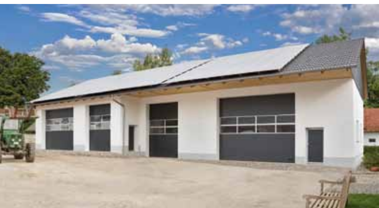
Moderne Lagergebäude setzen auf robuste Tor-Konstruktionen.
