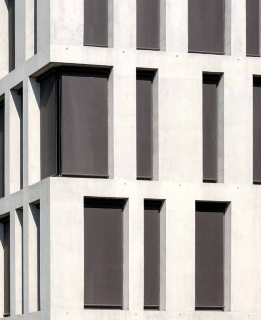
Trotz des großen Baukörpers wirkt die Fassade nicht massiv.
