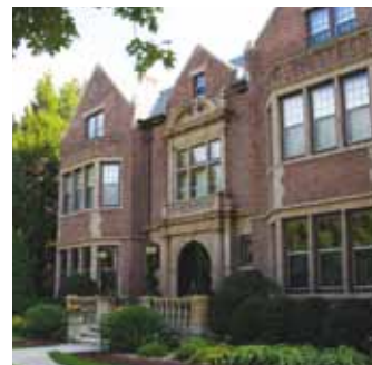
An historischen Gebäuden bleibt das Erscheinungsbild trotz der Fensterfolie erhalten.
