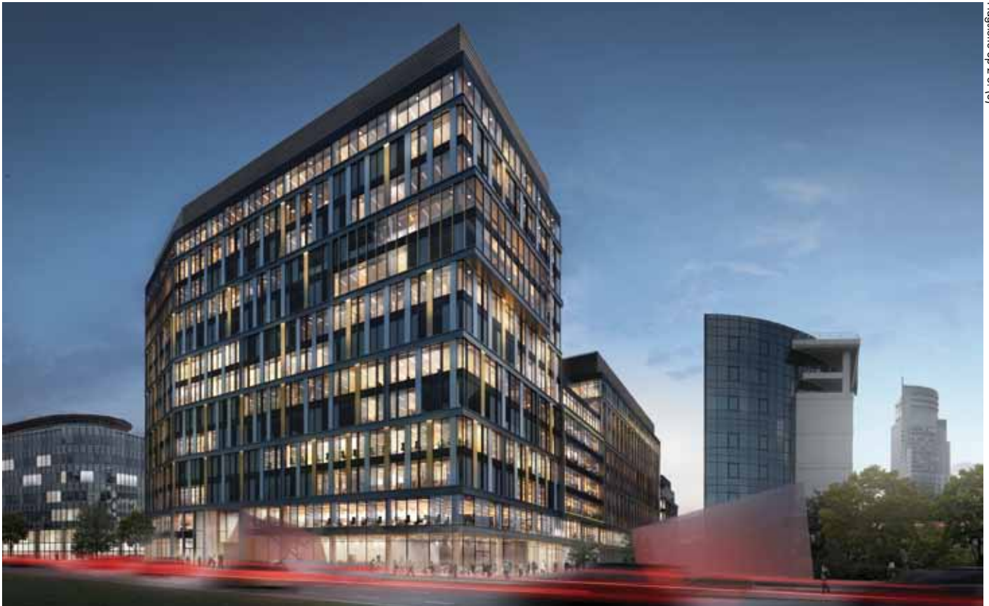
Der Bürokomplex Proximo besticht durch ein hohes Maß an Ästhetik und Funktionalität dank modernster technischer Ausstattung.
