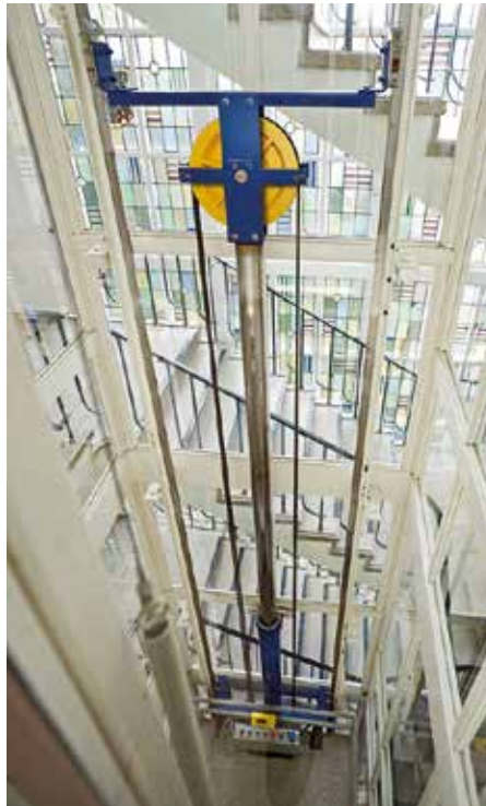
Umlenkrolle in indirekt-hydraulischer Aufzugsanlage / Deflection pulley in indirect hydraulic lift
