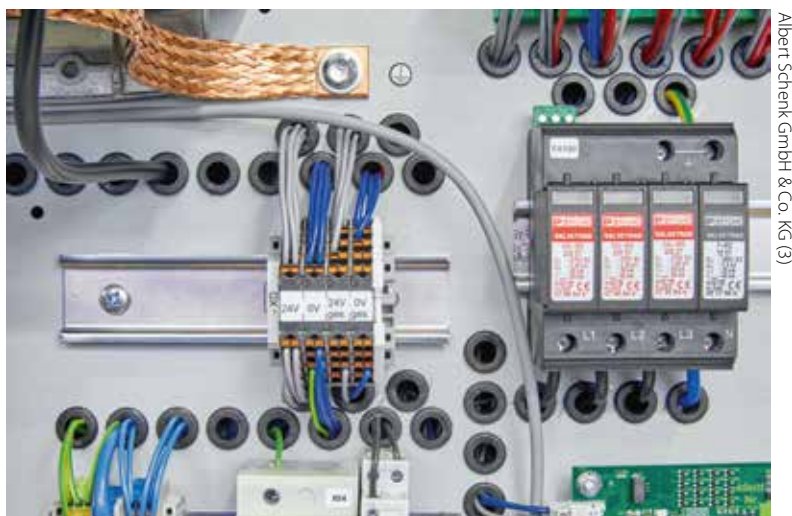
Die Push-in-Klemmen der Baureihe PTRV aus dem Cline complete-Programm sorgen für die Potenzialverteilung (links) – die modularen und steckbaren Ableiter schützen die Aufzugssteuerung vor Überspannungen (rechts). / The push-in terminals of the PTRV series from the Cline complete programme range provide for the potential distribution (left) – the modular and plug-in arresters protect the lift control against overvoltage (right).
