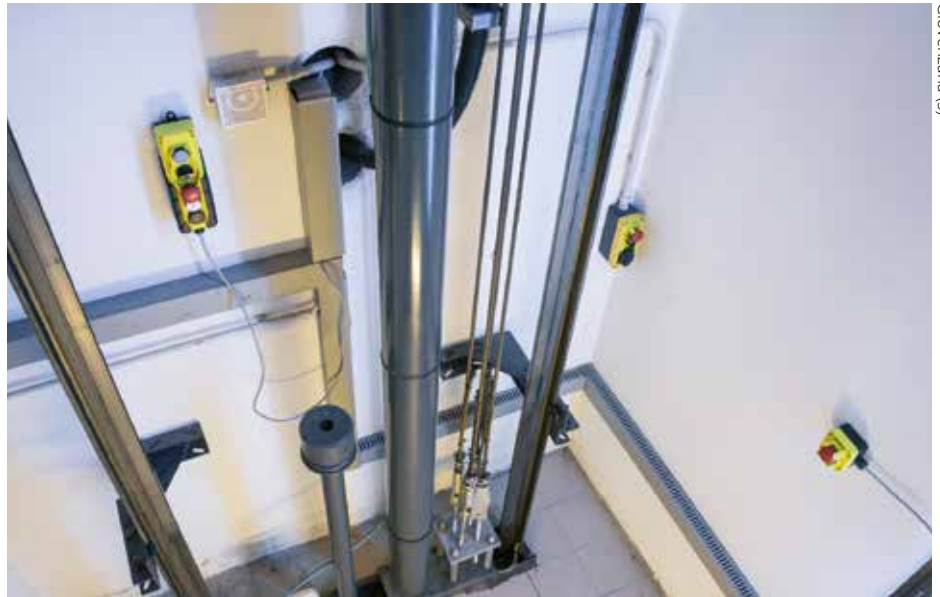
Installationen in der Schachtgrube / Installation in pit
