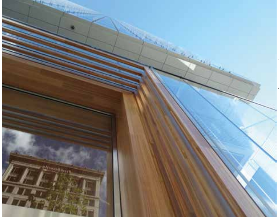
Die Eingangshalle des Gebäudekomplexes „111 South Main“ in Salt Lake City beeindruckt durch fast elf Meter hohe Fassadenscheiben, in die zum ersten Mal Holzurniere einlaminiert wurden.
