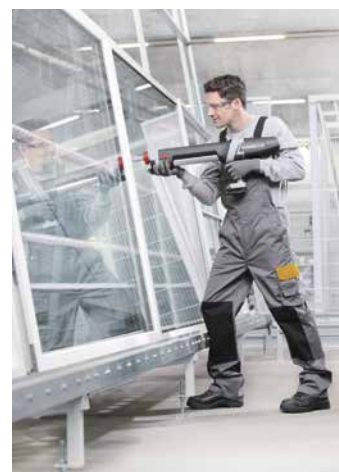
Aufgrund seiner hohen Dehnungsaufnahme bei guter Festigkeit lässt sich der Klebstoff sowohl im Sonderbau als auch bei Objekten einsetzen.
