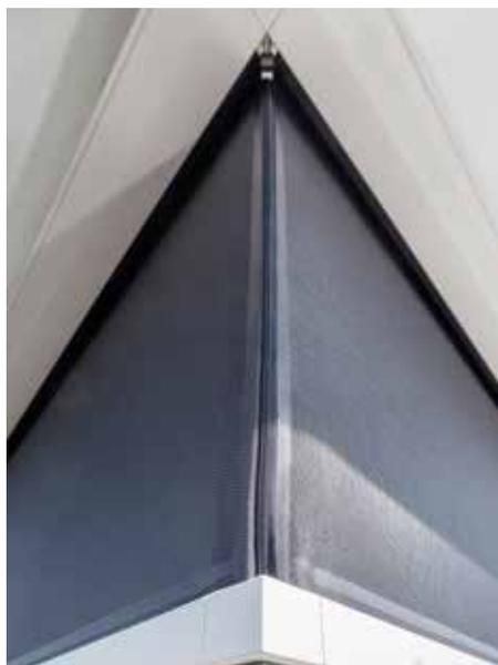
Beim Herunterfahren des Sonnenschutzes fahren beide Tuchteile in der Ecke in einen Reißverschluss ein und sind somit miteinander verbunden.
