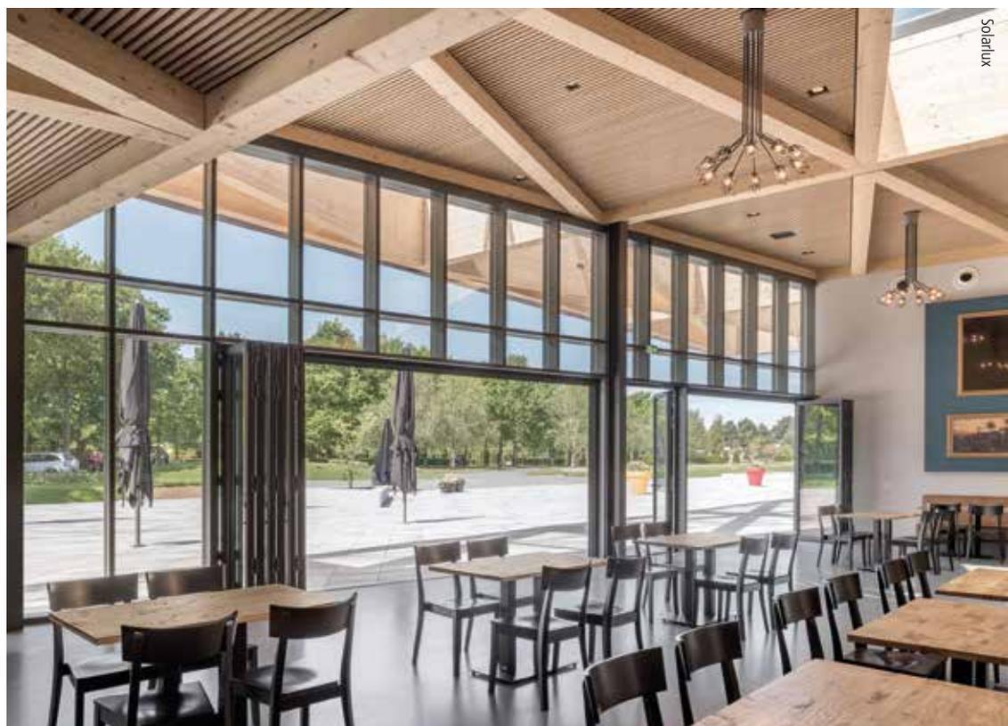
Konstruktionen. Ebenso überzeugend ist das Zusammenspiel der unterschiedlichen Details: So lassen die leichtgängigen Edelstahlauflagen auch bei sehr großen Glaselementen immer ein einfaches Bedienen per Hand zu und sorgen zugleich für die Langlebigkeit des Systems. Geschlossen bleibt die Glas-Faltwand hochtransparent: Ausführungen mit Oberlichtern, Fest-, Dreh-Kipp- und Eckelementen werden in nur einem Rahmen kombiniert. Dabei entfallen konstruktive
