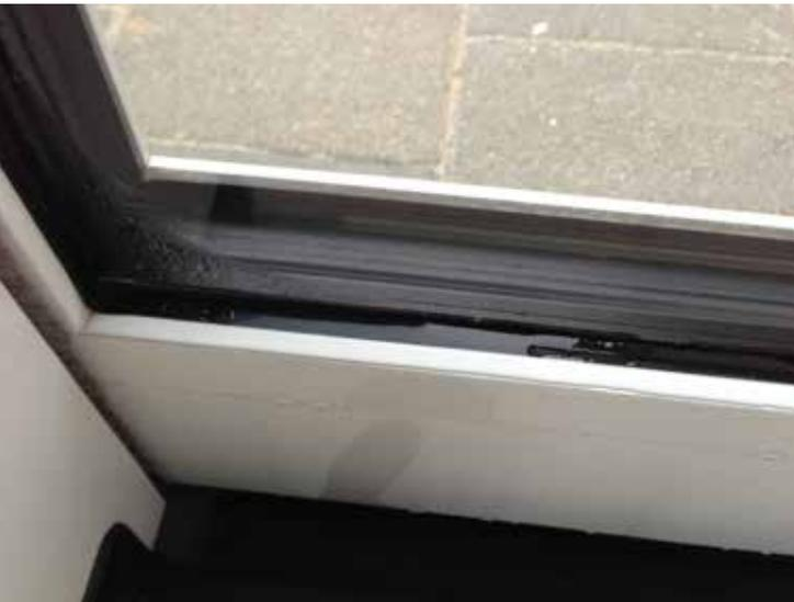
**Abbildung 2: Der Kritikpunkt: Kondensatbildung vor allen in den Morgenstunden im unteren Bereich der Verglasungen.**
