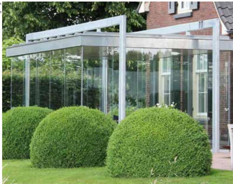
Bewegliche Glaswände in Form von Schiebe- und Schiebe-Dreh-Systemen bieten flexible Möglichkeiten zum Schutz vor schlechtem Wetter.
