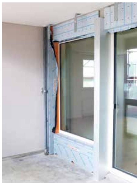
Fenster und Balkonzugang: Gut gedämmt mit Calostat.
