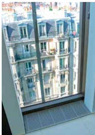
In einem Bürogebäude in Paris wurden über 650 LTG-Geräte FVPpulse eingesetzt.
