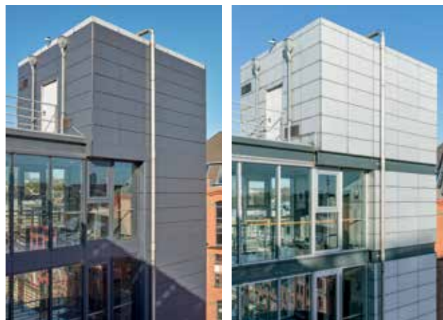
Die Metall-Fassade des Treppenhauses wurde komplett neu foliert. Rechts: Zustand vor der Sanierung.
