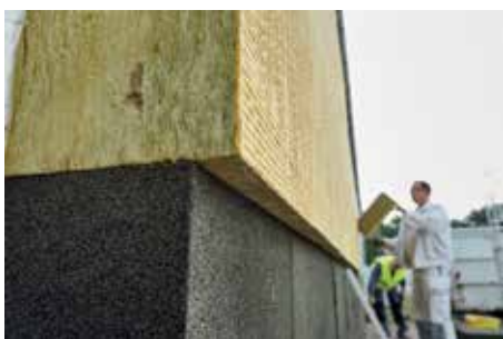
Ein mineralisches, nichtbrennbares Sockelsystem rundet ein WDV ab.
