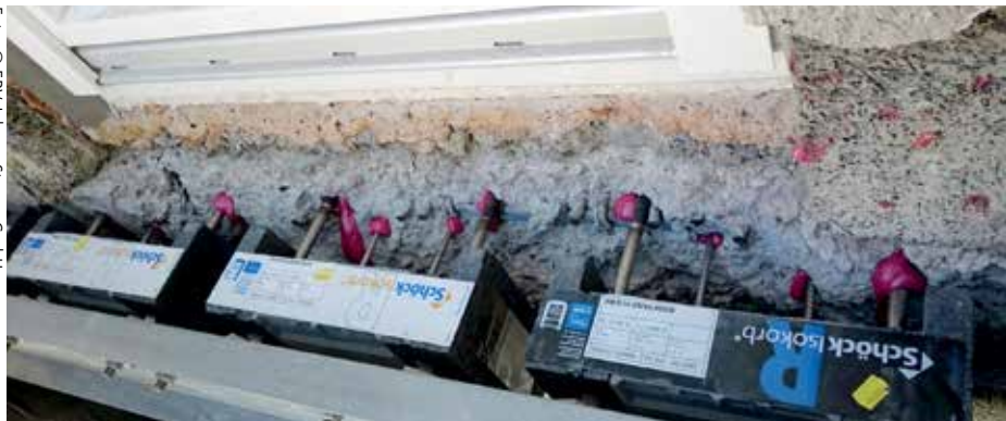
Für die thermische Trennung der Balkone wurde der Schöck Isokorb Typ RKS verwendet.
