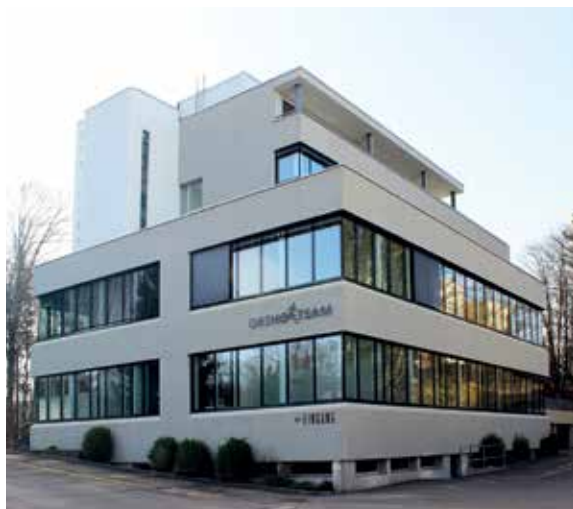
Die Fensterbänder sind mit dem Fassadensystem Schüco FWS60 CV realisiert worden.
