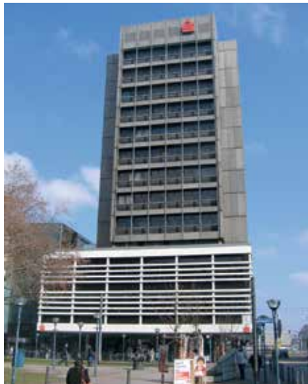
Bild 1: Das Sparkassen-Gebäude in Ludwigshafen.
