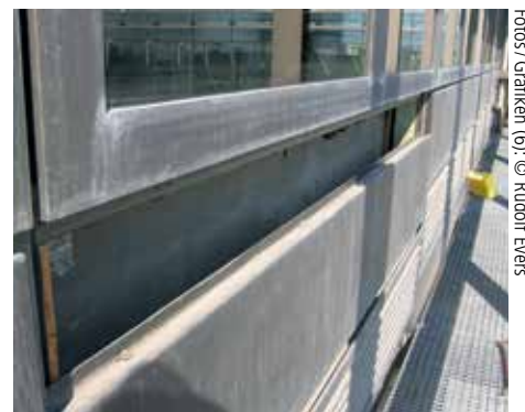
Bild 3: Fassade im Brüstungsbereich.
