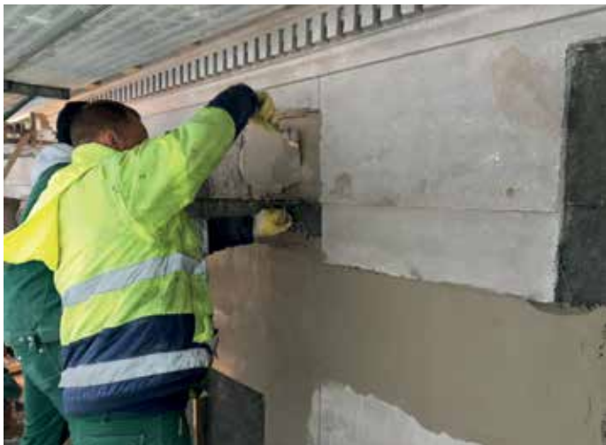
Auftrag des Remmers Restauriermörtels an der Sandsteinfassade.
