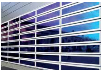
Fassadenintegriertes Photovoltaik-System – hier das Pilot Siding an einem Gebäude in Kreuztal.
