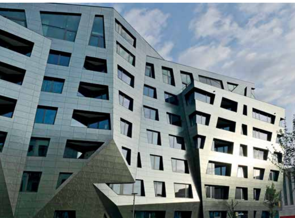
Die unsichtbare Befestigung der vorgehängten hinterlüfteten Fassade erfolgte mit speziellen Hinterschnittankern von Keil.
