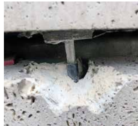
Bild 2: Dornausbruch infolge thermischer Zwängung.
