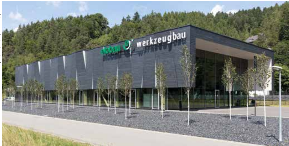
Mit Schiefer bekleideter Neubau einer Produktionshalle der Elobau in Probstzella.
