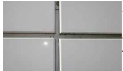
Kreuzfuge mit erlaubter Toleranz.
