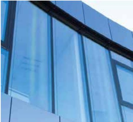
Typische Anisotropie-Erscheinungen in Architekturglas. Die mittlere Scheibe im Bild wurde in einem optimiertem Vorspannprozess hergestellt und zeigt keine störenden optischen Effekte.
