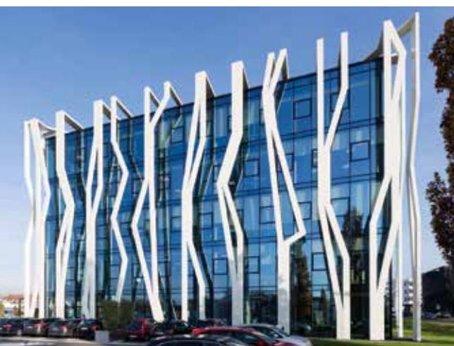
Bei QBIG III sind die Stahlstreben vor der Glasfassade asymmetrisch vertikal angeordnet.
