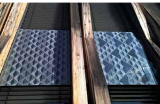
Photovoltaikmodul mit architektonischem Siebdruck.
