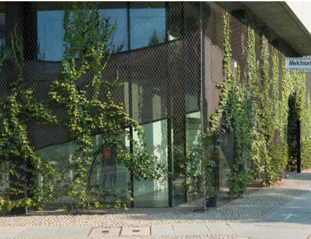
Edelstahlnetze vor der Fassade wie bei diesem Berliner Wohnhaus bieten selbst in unbegrütem Zustand einen guten Vogelschutz.
