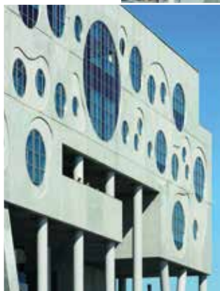
Die Fassade besteht aus einer Kombination von glattem Sichtbeton sowie Kassetten aus Aluminiumverbundplatten.
