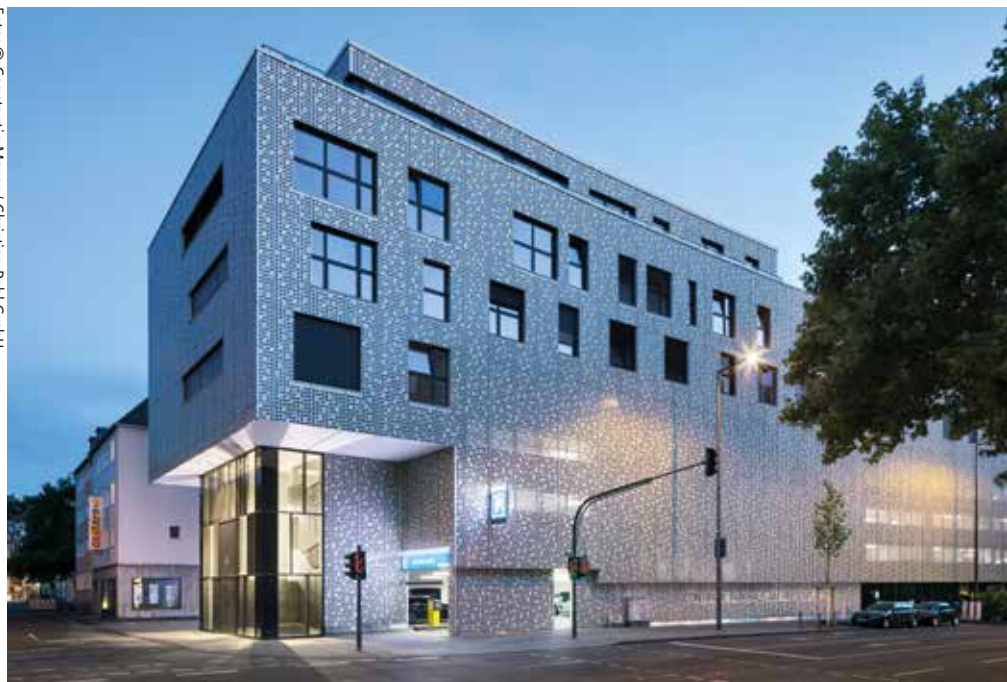
Von außen ist auf den ersten Blick gar nicht erkennbar, dass in diesem Objekt auch gewohnt wird.
