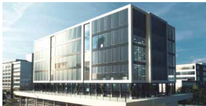
Der Sonnenschutzbehang hält auch bei stärkerem Wind.
