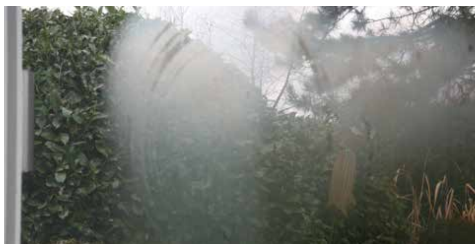
Foto 1: Saugerabdrücke, die nur auf einer kondensierten Scheibe sichtbar sind.
