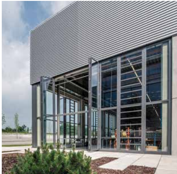
Zu Lüftungszwecken wurden die Glas-Faltwände von Solarlux mit Lamellenfenstern von Fieger ausgestattet.
