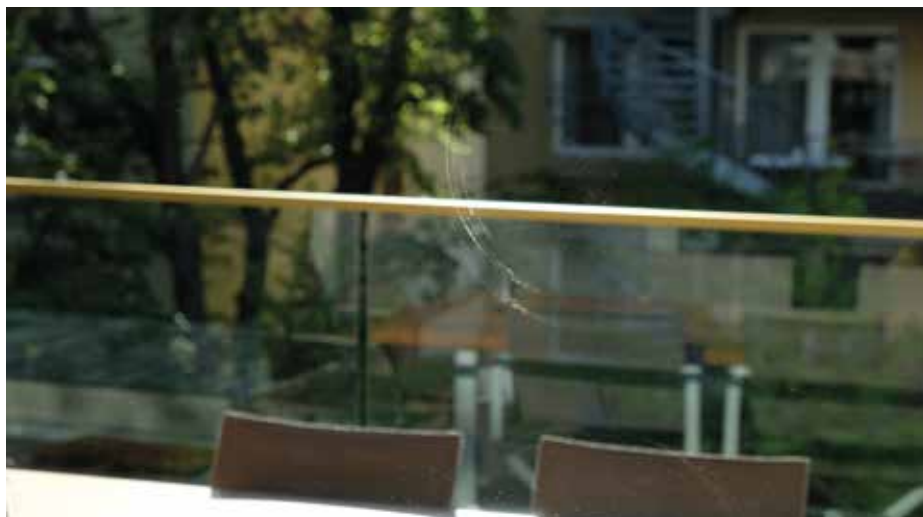
Foto 2: Saugerabdrücke, die nur bei Sonnenschein sichtbar sind.
