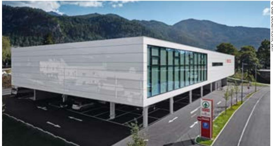
Nordwestansicht Eurospar Kufstein: Die Glas-Sandwich-Fassade kombiniert großzügig opake Anteile mit einer Pfosten-Riegel-Fassade. Die Glasspiegelungen geben immer wieder neue Eindrücke der Umgebung und des Bergpanoramas wieder. Mit einer Elementlänge von bis zu 14,72 Meter entsteht ein ruhiges Fugenbild.
