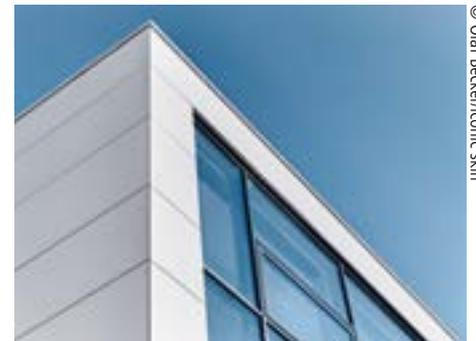
Der Übergang von GSP zu Fenster-, Türen- oder Fassadensystemen erfolgt durch Anschlussprofile.
