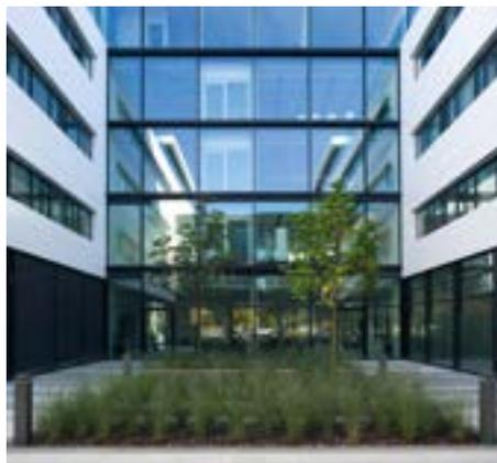
Einen schönen Kontrast zur Pfosten-Riegel-Fassade bildet die vorgehängte hinterlüftete Fassade mit weißem Corian (Acrylstein).
