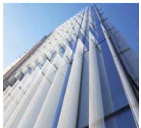
Das Aufsetzen der Glasschwerter auf die Glasfassade erzeugt vertikale Strukturen, die auch weiterhin für das markante Erscheinungsbild des Gebäudes sorgen.
