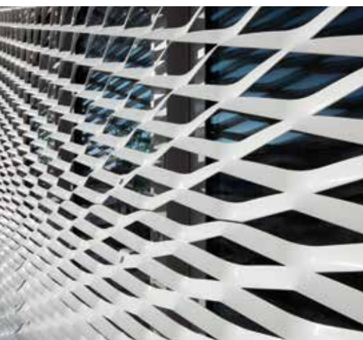
Die edle Farb-Kombination besteht aus weißem Streckmetall und hellgrauem Blech dahinter.
