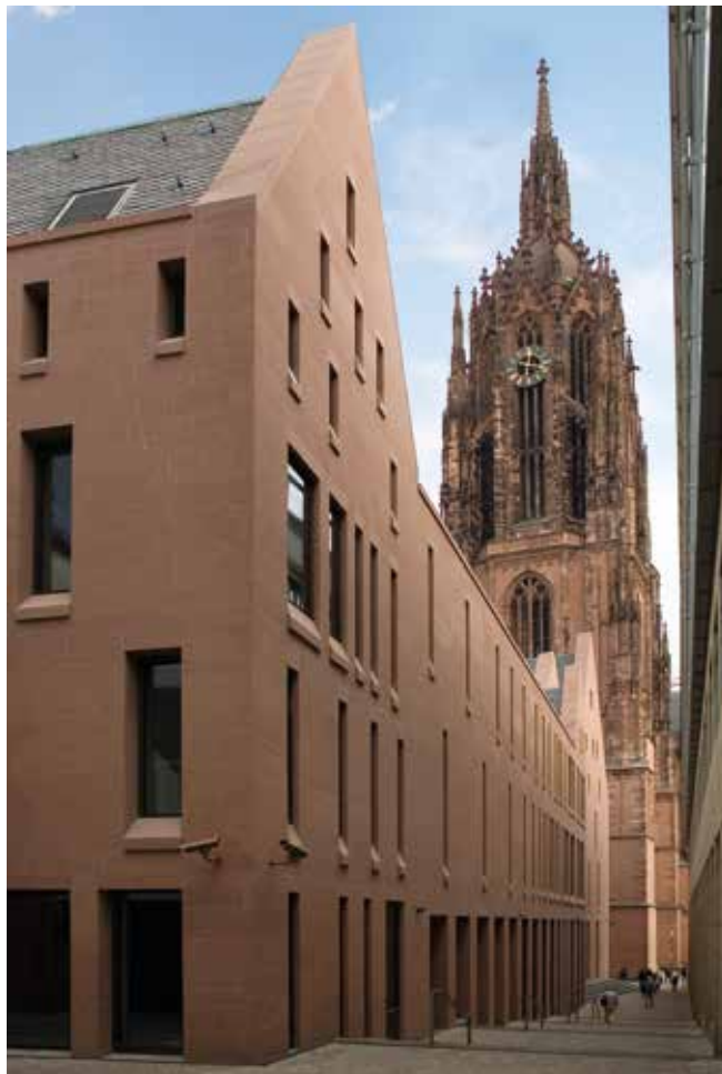
Das Stadthaus am Markt (SAM) überzeugt mit einer Natursteinfassade aus Wüstenzeller Sandstein.
