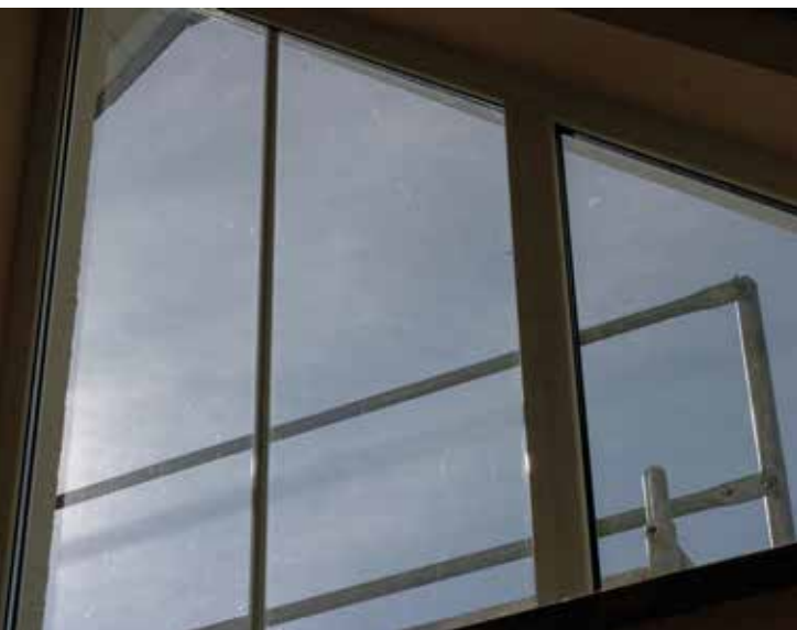
Im Durchblick gegen Bewölkung kaum sichtbar, mindern Schäden in den Glasoberflächen bei Sonnenlicht den hier ansonsten hochwertigen Eindruck des Wohnraums.
