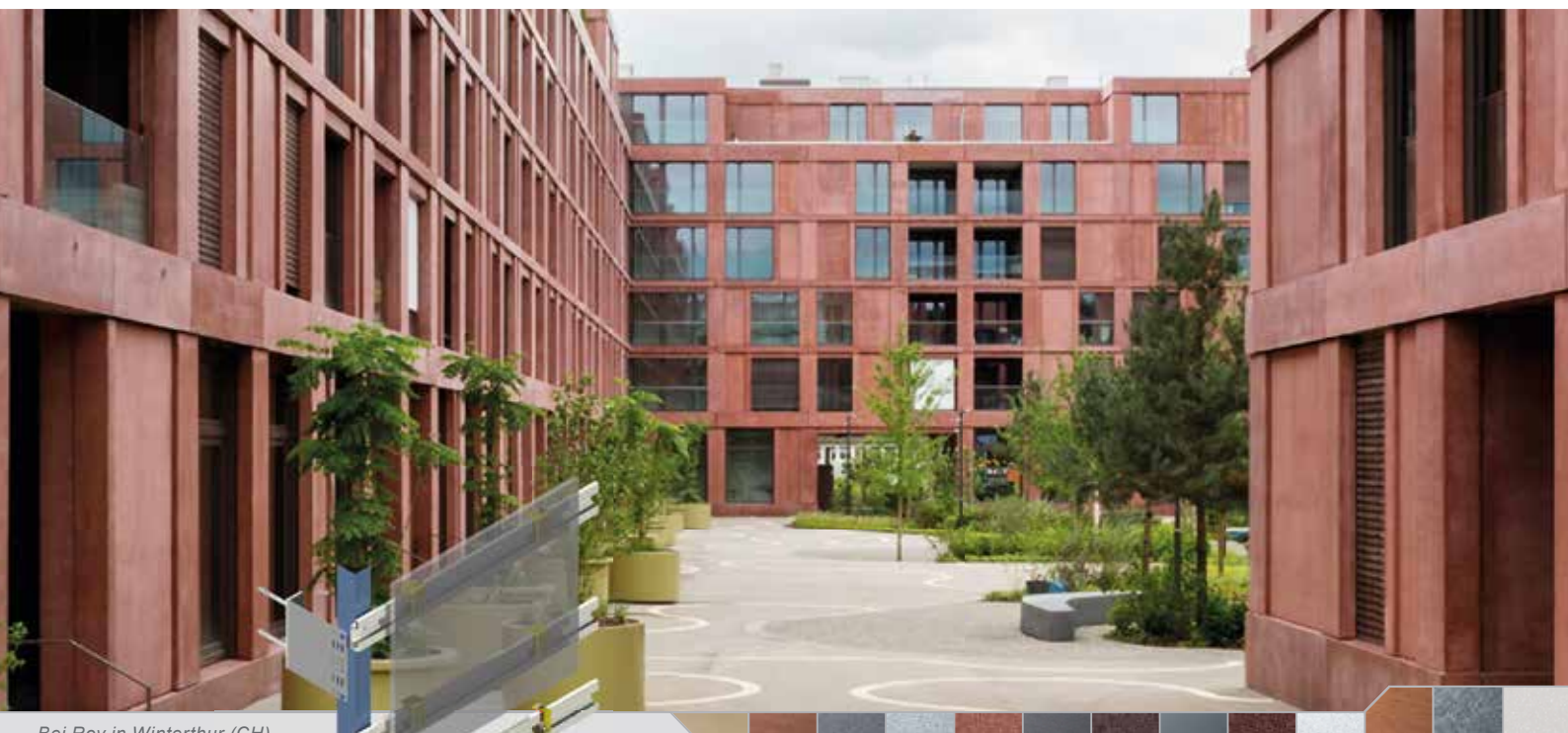
Bei Roy in Winterthur (CH) kam UBE 25 NG2 mit rückseitig verdeckter Befestigung zum Einsatz.
