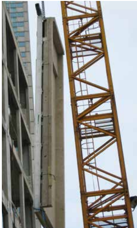
Montage einer elementierten Natursteinfassade.
