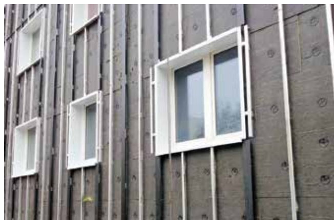
Die Unterkonstruktion einer VHF.
