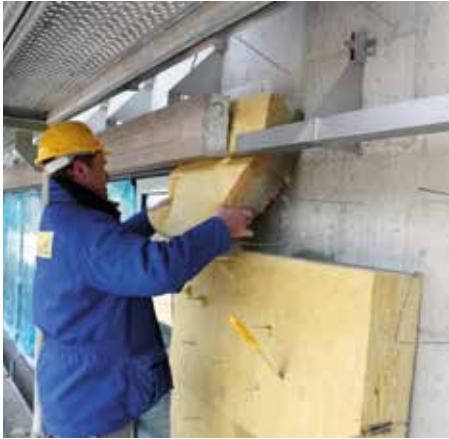
Die Kerndämmplatte ist leicht handhabbar und lässt sich auch im Bereich von Bauteilanschlüssen flexibel einsetzen.
