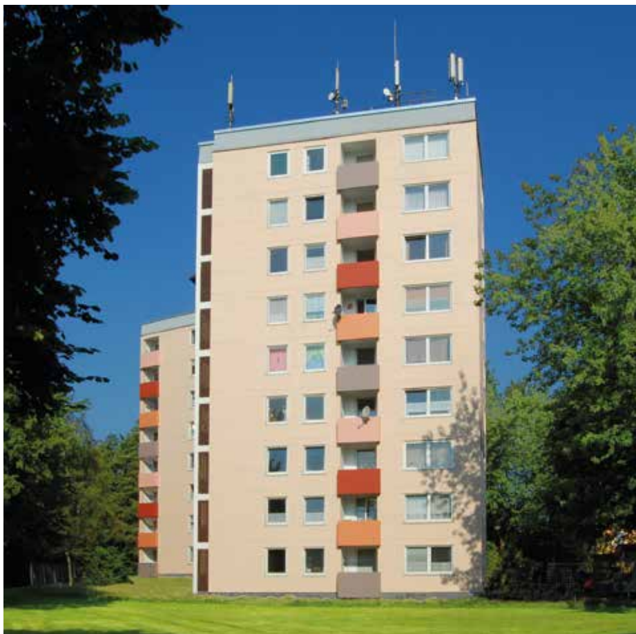
Das Wohnhochhaus am Hermelinweg 15 nach der Sanierung.
