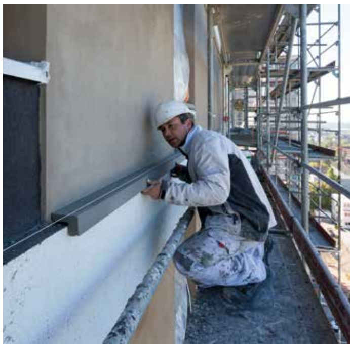
Montage der Capapor-Profile, die die Fassade horizontal gliedern und in den Bereichen der Loggien sowie Balkone die sonst übliche Verblechung übernehmen.
