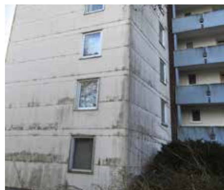
Teilansicht Hermelinweg 15 in Oldenburg vor der Sanierung.
