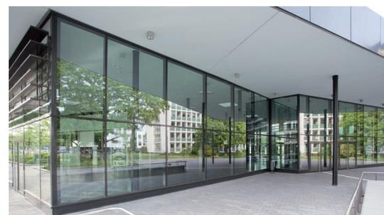
Integriert in die Isolierglasscheiben wurde die PVB-Folie Trosifol® SC Monolayer in 0,76 Millimeter Dicke.
