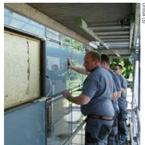
Die Montage der Pfosten-Riegelkonstruktion verlief reibungslos.
