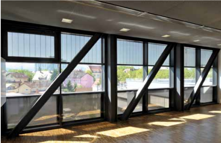
Seminarraum-Glasfront am Fraunhofer ISE: Im unteren Bereich sind PVShade Module in die Fassade integriert. Im oberen Bereich ist ein herkömmlicher beweglicher Sonnenschutz zu sehen.
