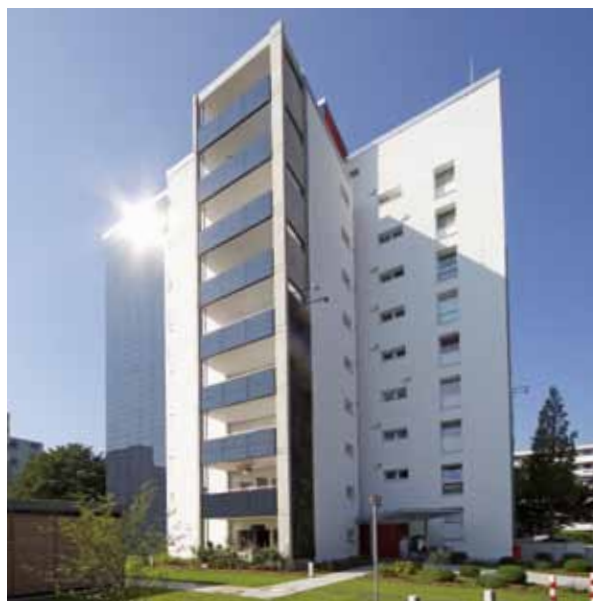
Das neugeschossige Hochhaus in der Eislebener Straße 75 wurde komplett saniert.
