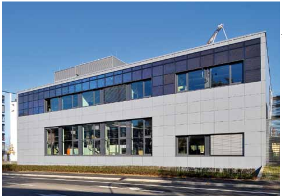
Fassadenintegrierte MWT-Siliziummodule an einem Laborgebäude des Fraunhofer ISE.
