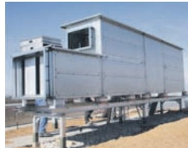
Doppelt elastische Lagerung einer Klimaanlage mit KSD-Elementen / Double elastic bearing of an air conditioning system with KSD elements.
