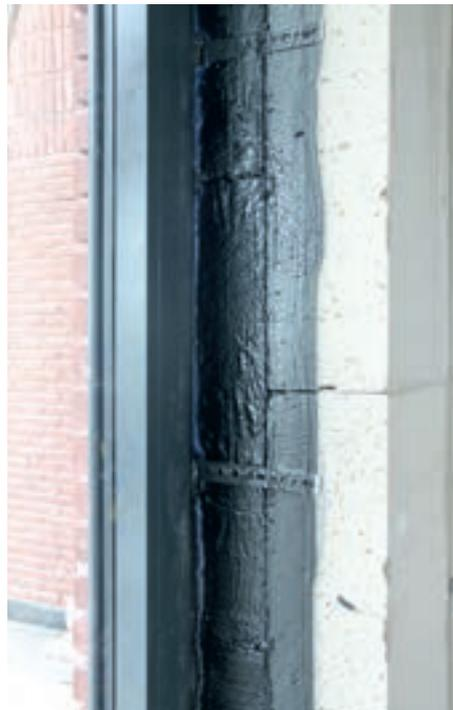
**r.:** Frisch aufgetragen hat die Soudatight-Polymerpaste eine hellblaue Farbe. Nach vollständiger Austrocknung wechselt sie den Farbton und bildet eine schwarze, luft- und dampfdichte, elastische Membran. Diese kann problemlos überstrichen und verputzt werden.
