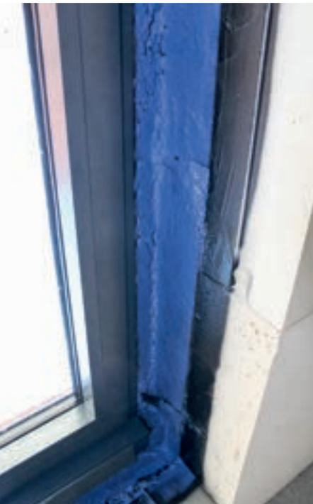
**l.:** Besonders schwierig wird es, wenn zwischen Fensterrahmen und Mauerwerk Unebenheiten, größere Vertiefungen, Befestigungsanker oder ähnliches zu überbrücken sind. Hier bietet Soudal mit der neu entwickelten, flüssigen Dichtpaste Soudatight eine echte Alternative.
