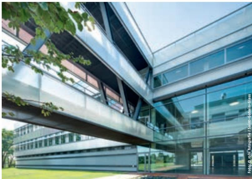
Bei diesem Projekt sind die Brüstungen der Fußgängerbrücken sowie der Fassade aus SGG Securit-H Estriado gefertigt.
