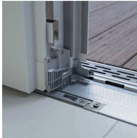
**I.:** Mit dem Combi Plan-System von Grundmeier gehören störende Türschwellen der Vergangenheit an. Es ermöglicht die Realisierung von einheitlichen Höhen von innerem und äußerem Boden und der Türschwelleoberkante.
