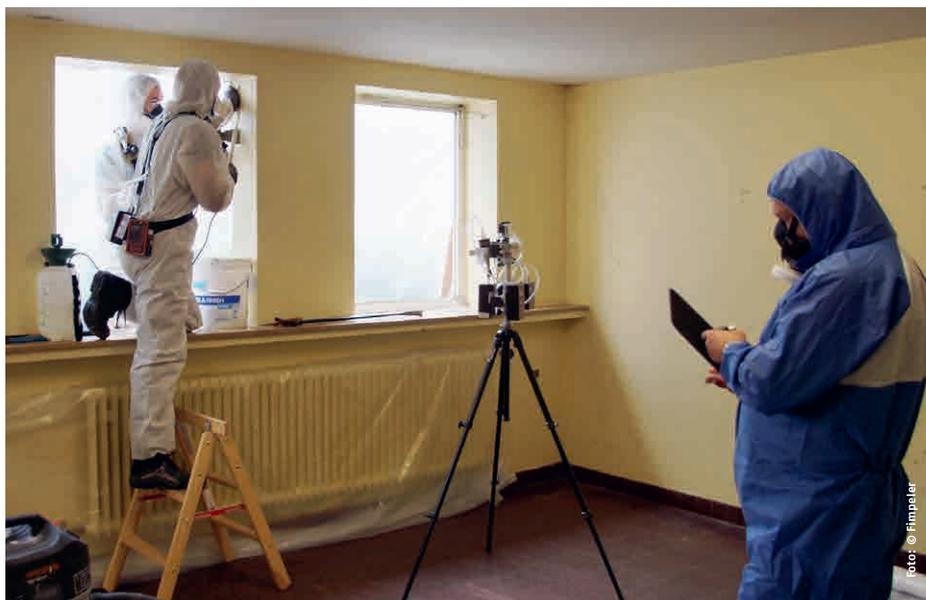
Der nächste Schritt: Erste Messungen zur Luftbelastung bei der Demontage von Fenstern aus asbesthaltigem Putz wurden bereits vom Bundesinnungsverband und der Berufsgenossenschaft Bau durchgeführt. Derzeit werden die Messergebnisse ausgewertet.
