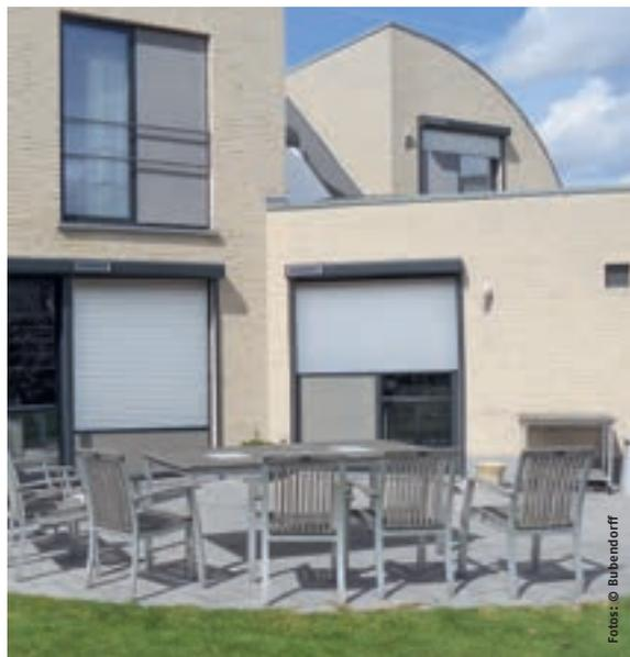
**l.** Das Photovoltaik-Panel kann oberflächenebenen in den Rollladenkästen integriert oder auch außerhalb platziert werden. Im Panel befinden sich auch die Sensoren (Temperatur + Licht) für die automatische Steuerung.
