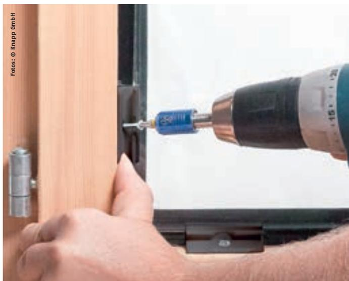
Der Anpressdruck bei der Verglasung mit dem neuen Einzelhalter FIXclip GLE 20 Plus erfolgt mittels Schrägverschraubung. Ein leichtes Einklicken der Glasleiste ist gewährleistet.
