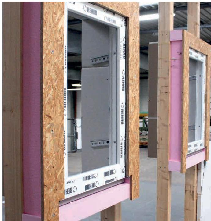
führen. Bei der Montage liegt daher ein besonderes Augenmerk auf der langfristigen wind- und schlagregendichten Ausführung der Anschlussfugen zwischen Bauteil und Baukörper. Den weitaus komplexeren Part übernehmen hier die Fenster- und Türenhersteller, denn auch Fenster und Türen selbst müssen absolut schlagregendicht sein. Dennoch müssen auch die „starrten Fugen“ sorg-
