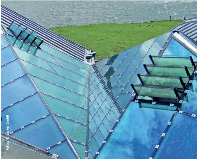
Links: Die bigAir Dach-Lamellenfenster lassen sich in Schrägdächer ab einer Neigung von zehn Grad einbauen.
