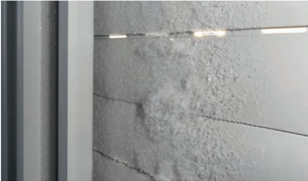
In extremen Fällen kann Eis über Rollladengurt-Öffnungen oder Dampfdruckausgleichsöffnungen bis in den Bereich des Rollladens vordringen und eine Funktionsstörung des Rollladens verursachen.
